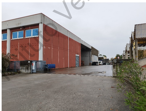
Ingresso lato est
