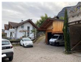
Accesso al Box auto al piano terra - Sub 22
