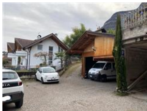
Accesso al Box auto al piano terra - Sub 23
