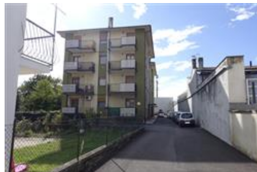
Facciata a Nord-Ovest
