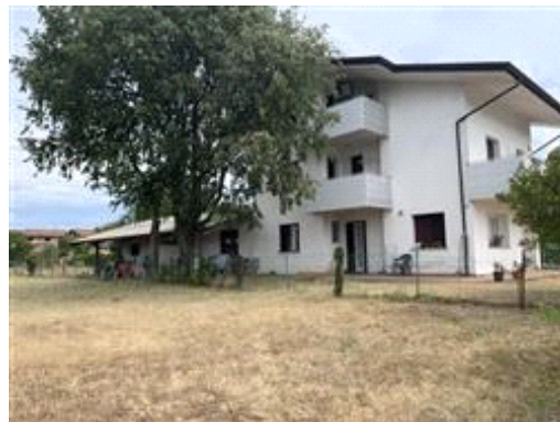
Fabbricato facciata ad ovest.
