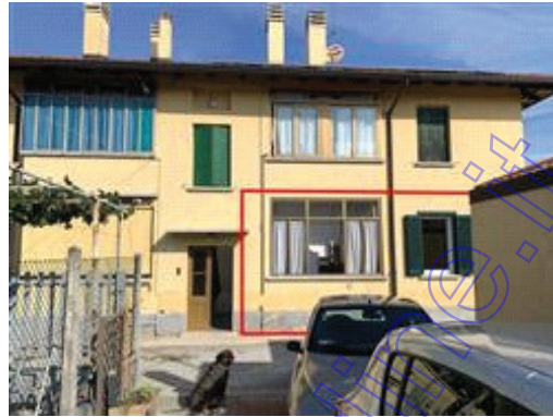
Prospetto sud dalla corte comune.
