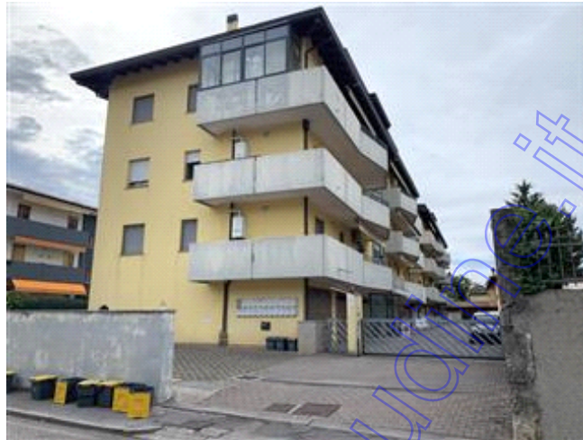
Complesso condominiale visto da via Della Cernaia.
