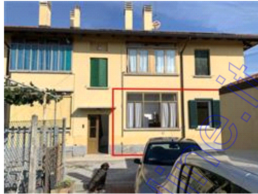
Prospetto dalla corte comune.
