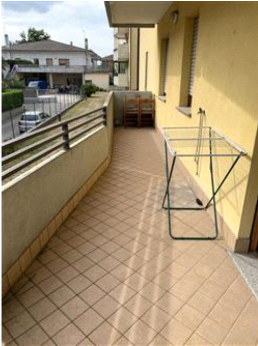
Balcone lato est.
