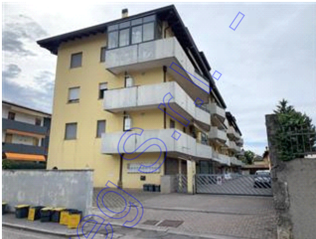
Complesso condominiale visto da via Della cernaia.
