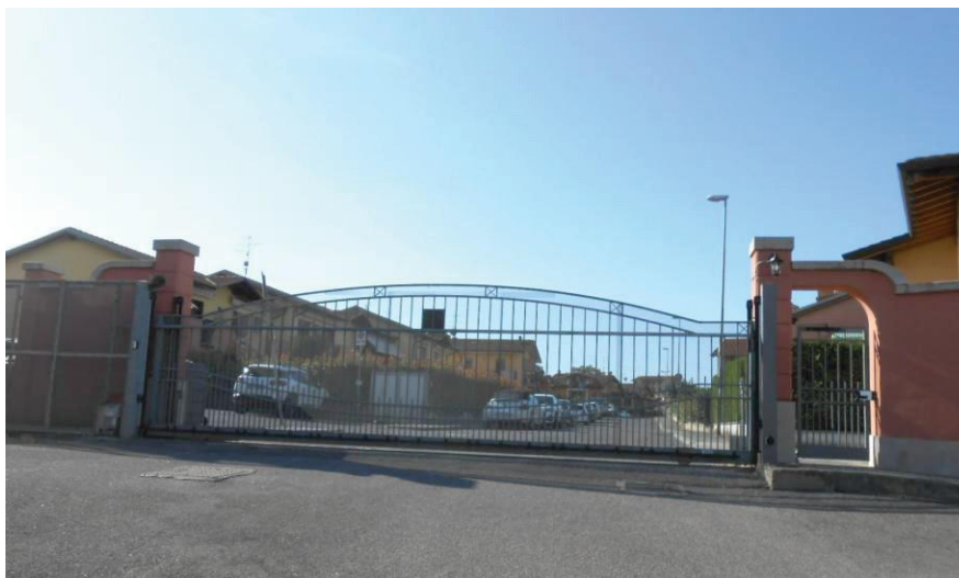
Immagine dell'ingresso al complesso edilizio
