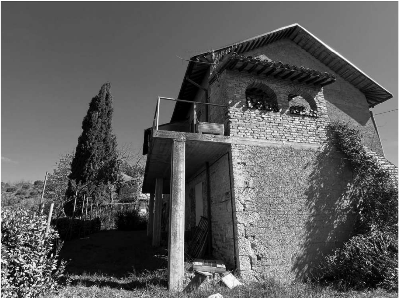
ESTERNO LATO SUD
