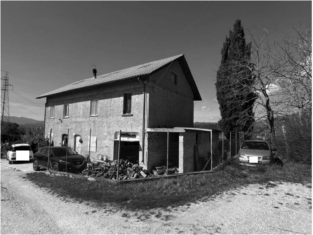
ESTERNO LATO EST
