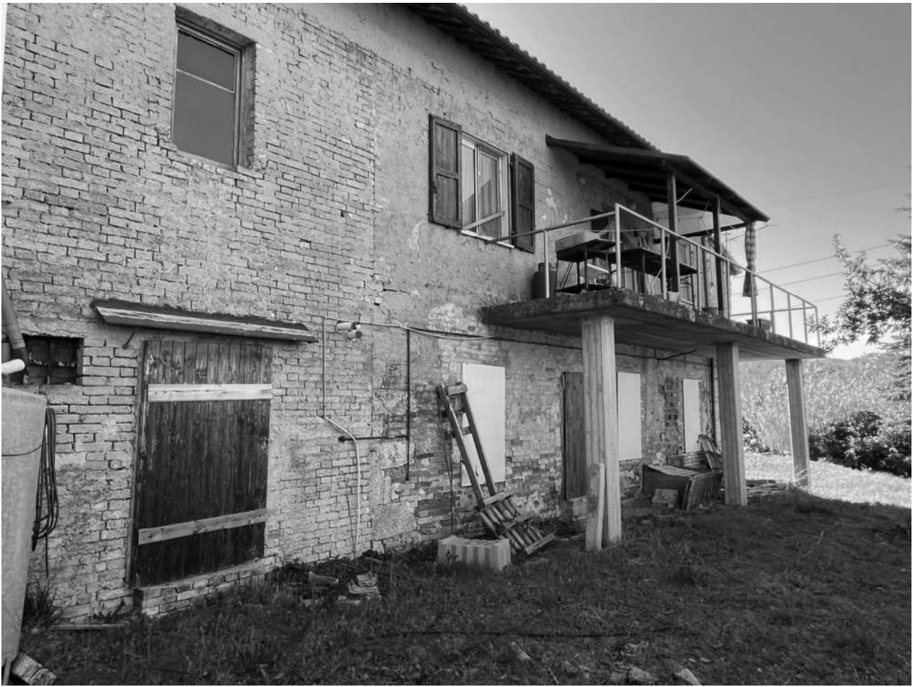
ESTERNO LATO OVEST
