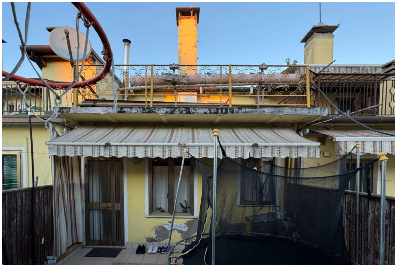
Foto n. 4) Vista del prospetto sud
