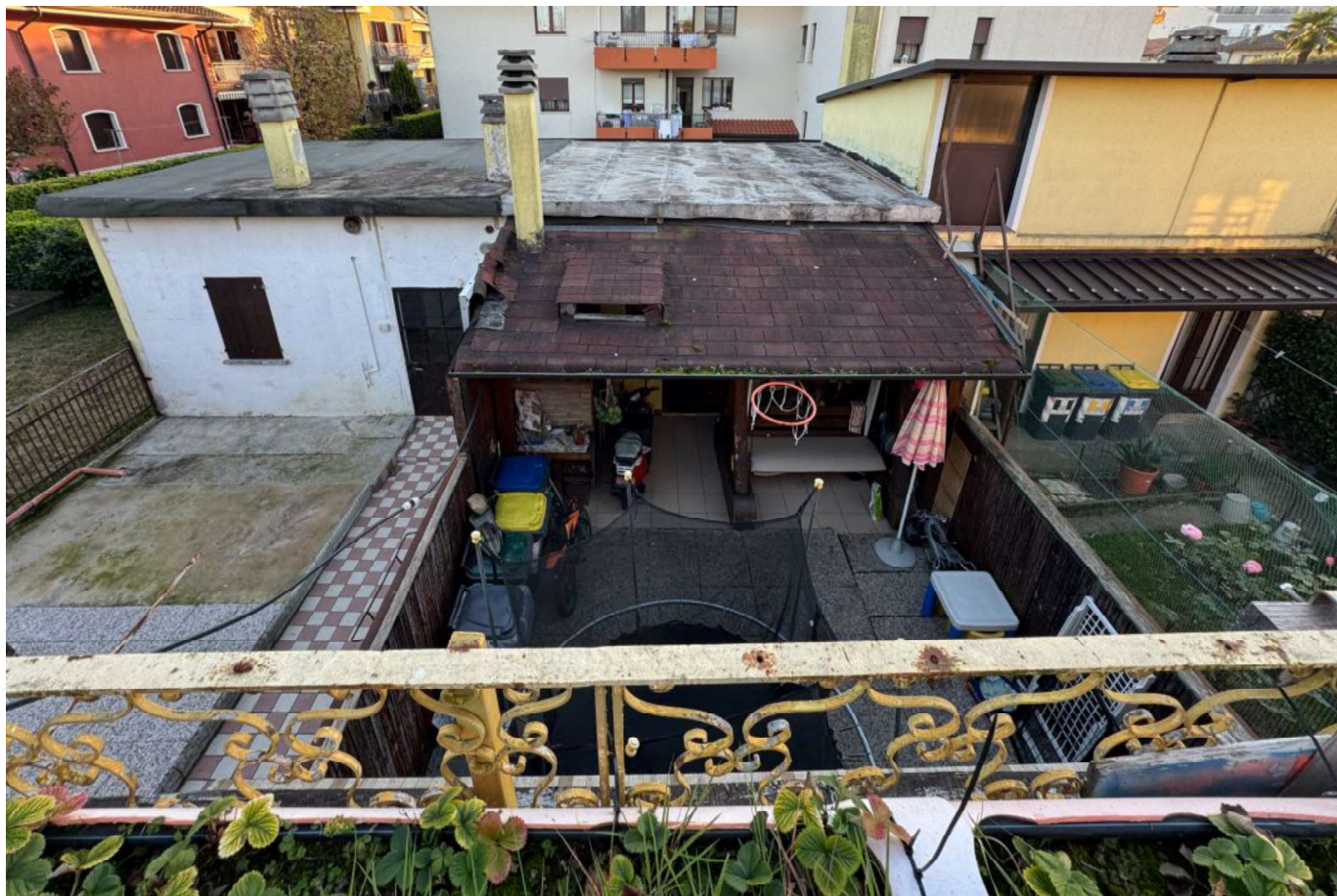
Foto n. 7) Vista della corte interna e della tettoia abusiva verso il garage
