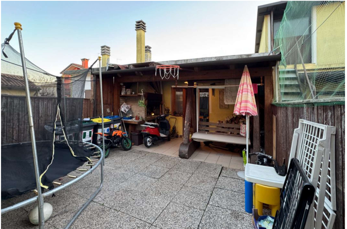
Foto n. 6) Vista del garage e della tettoia abusiva- prospetto nord
