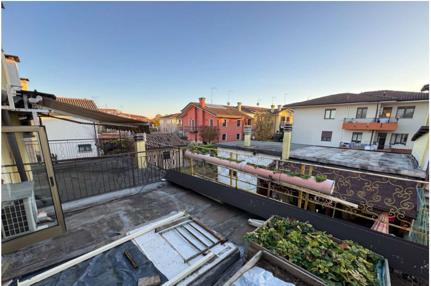
Foto n. 21) Vista del terrazzo
