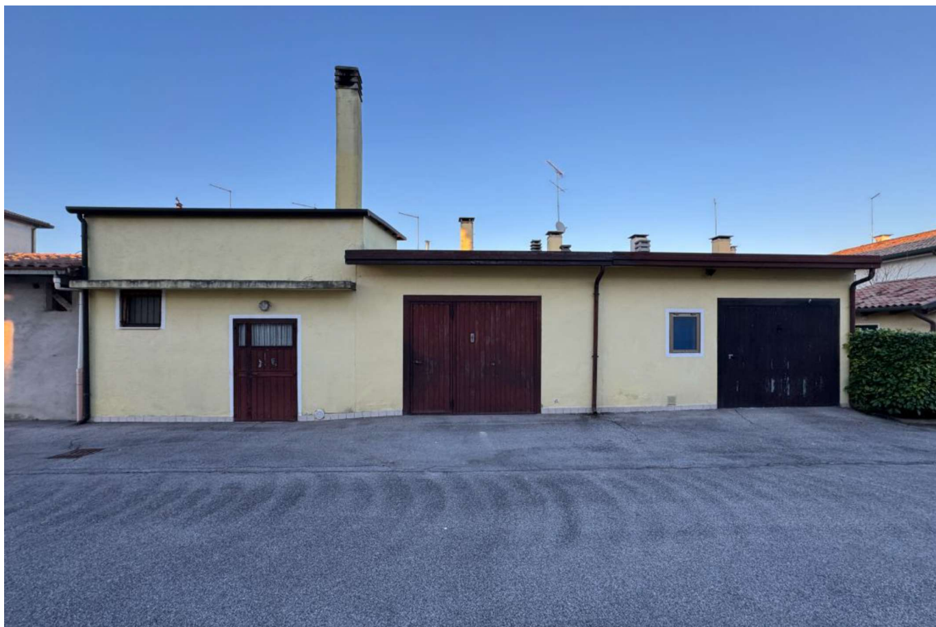
Foto n. 8) Vista del garage - prospetto sud
