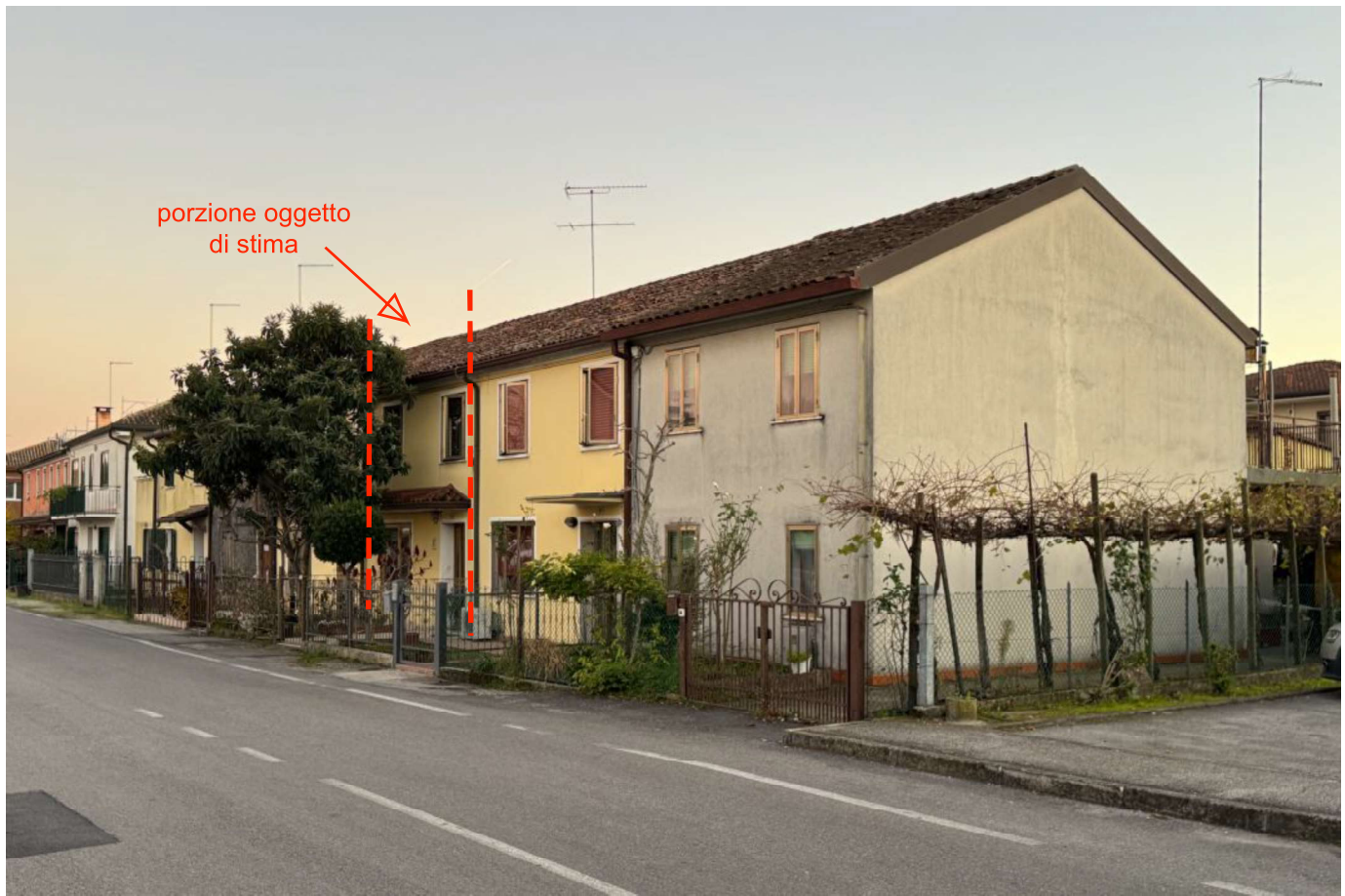
Foto n. 1) Vista del fabbricato da Via Roma
