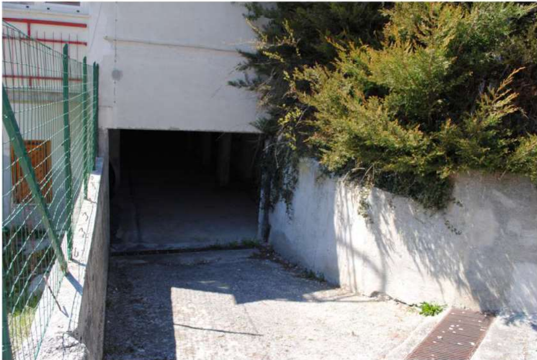
Foto 4 – Ingresso condominiale alle autorimesse e depositi
