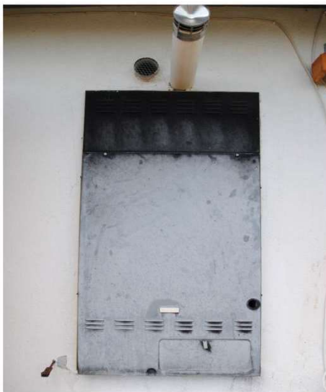
Foto 20 – Caldaia esterna
