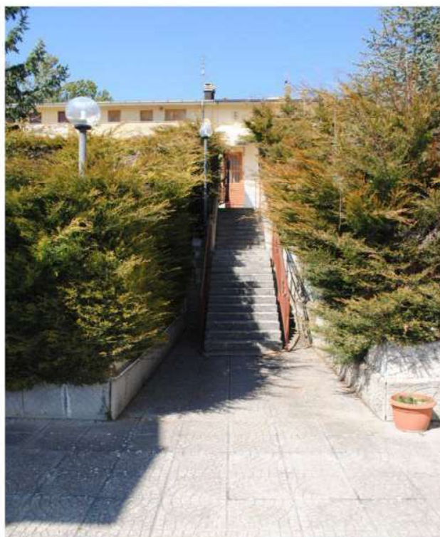
Foto 2- Scala di ingresso da via Colle della Croce
