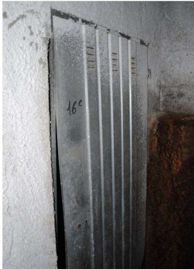
Foto 6 – Porta d'ingresso deposito
