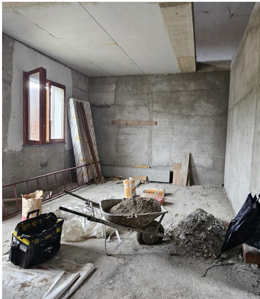
Unità al sub. 510: vista interna del Piano Terra
