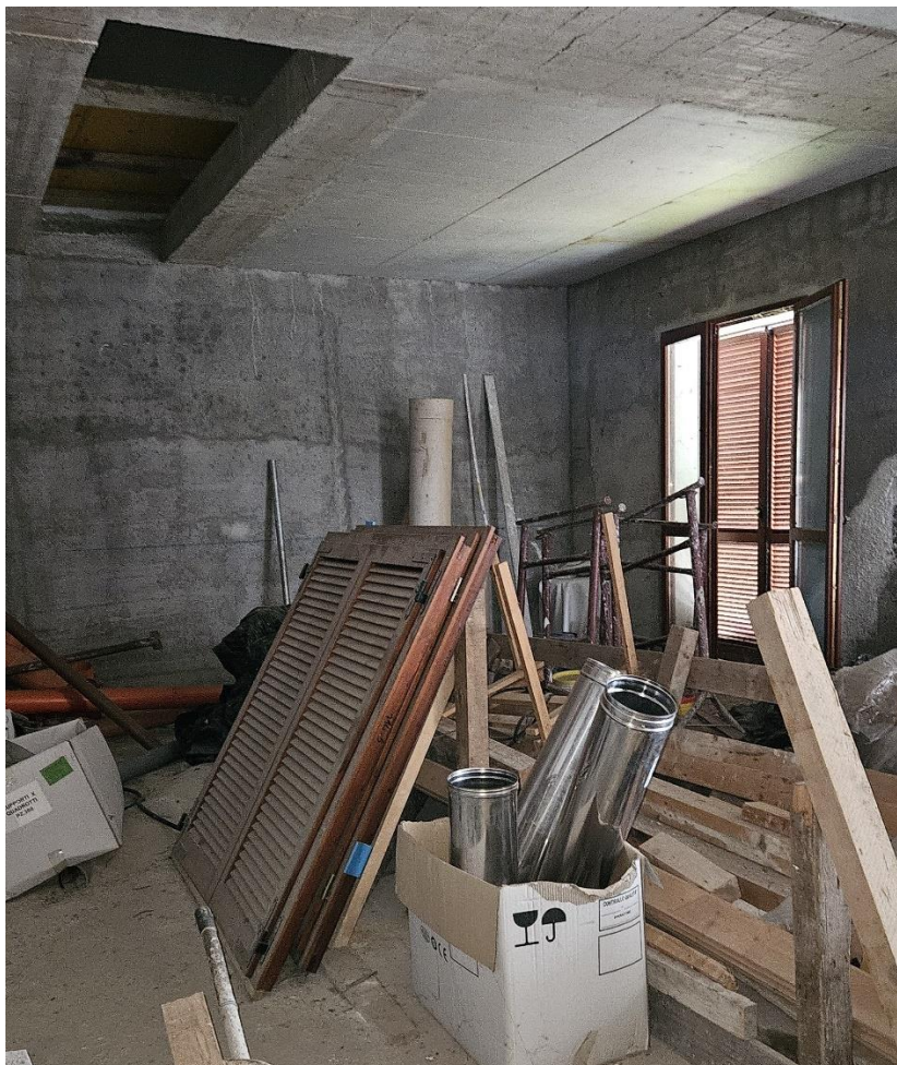
Unità al sub. 509: vista interna del Piano Terra
