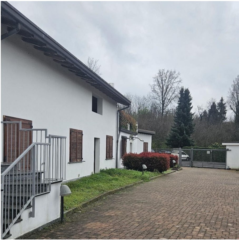
Vista del cortile di proprietà comune
