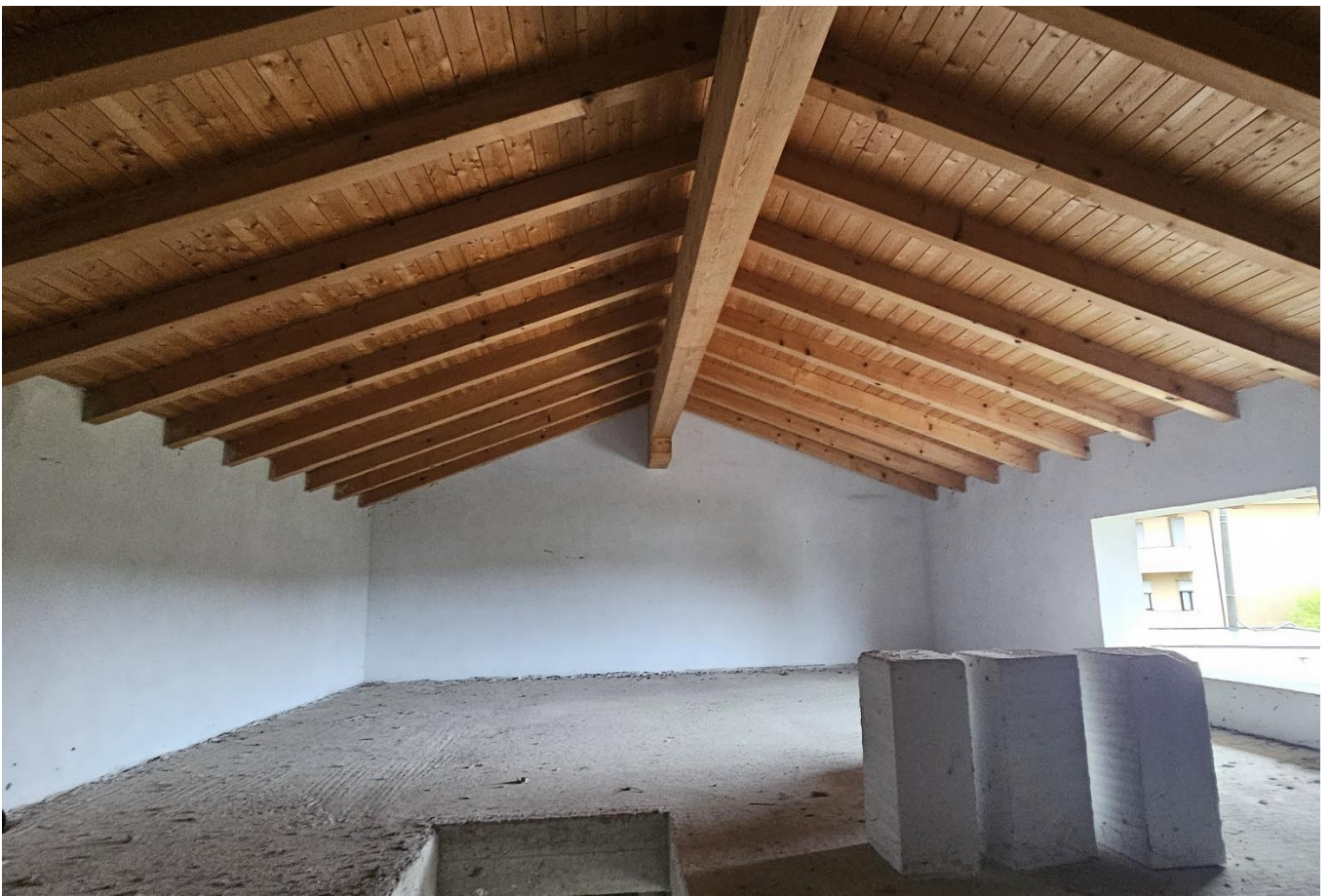
Unità al sub. 510: vista interna del Piano Sottotetto
