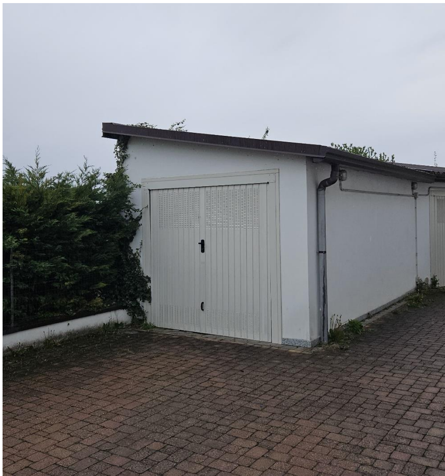
Vista dell' autorimessa al sub. 507
