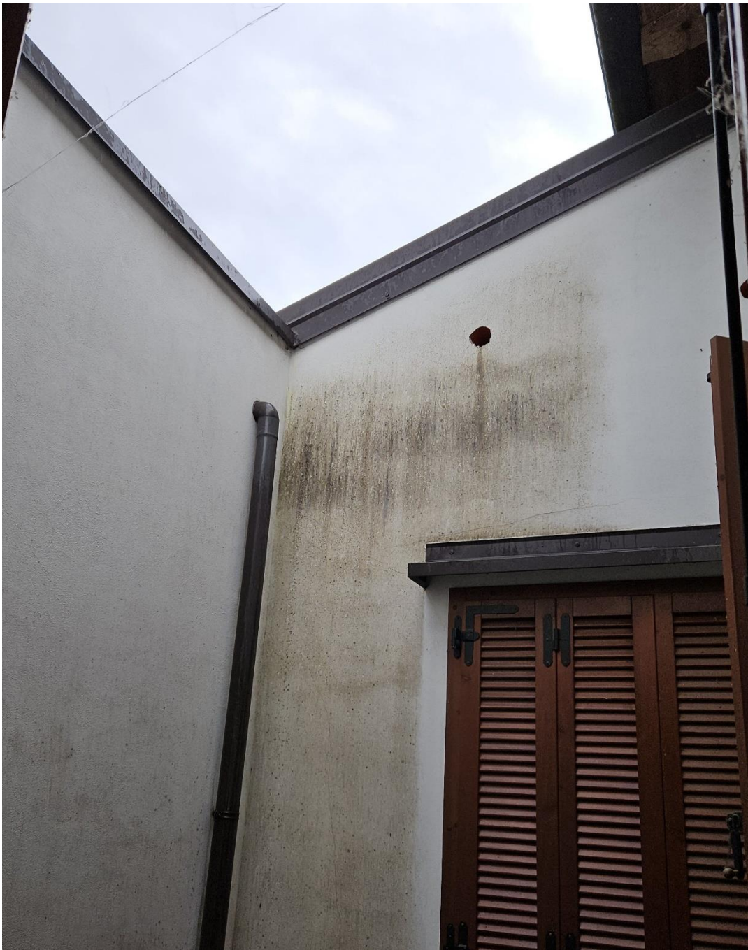
Particolare del cavedio dell' unità al sub. 509
