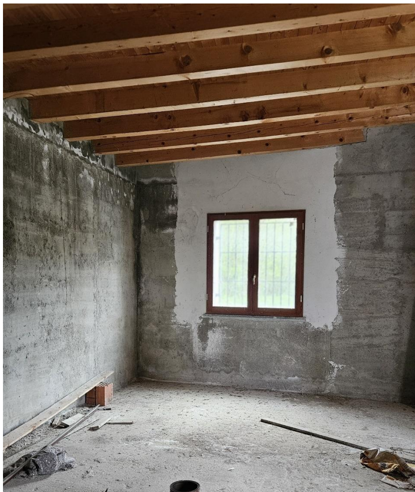
Vista interna dell' unità al sub. 512
