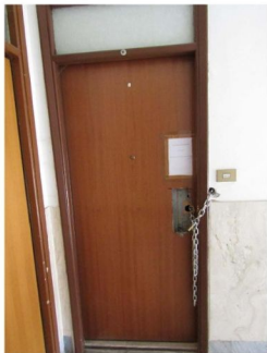
foto 32 porta d'ingresso appartamento.
