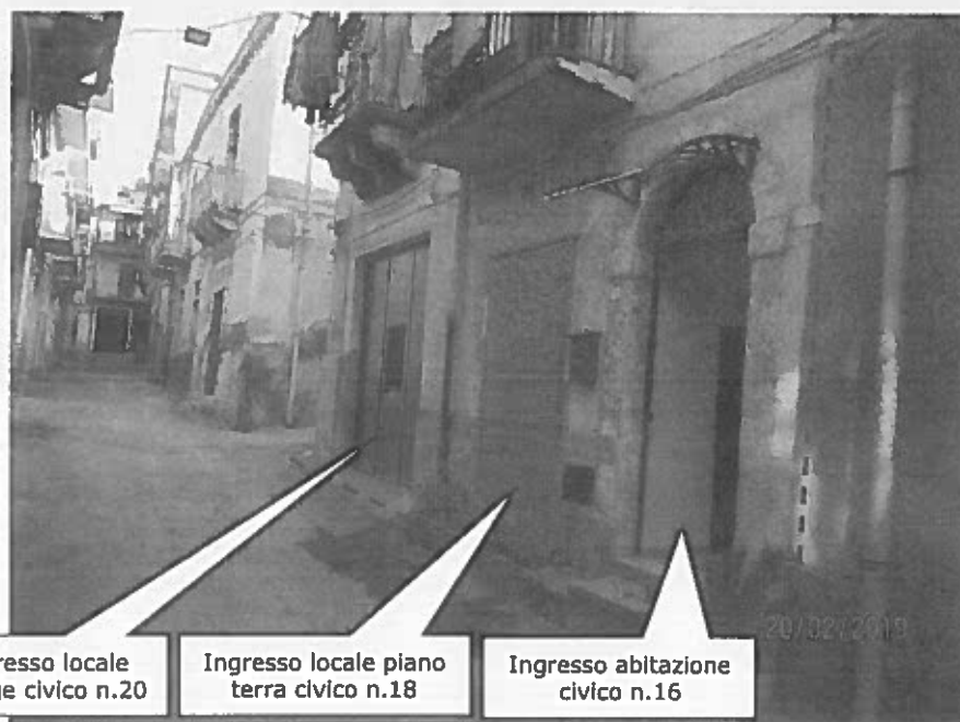
Prospetto principale via Umbria
