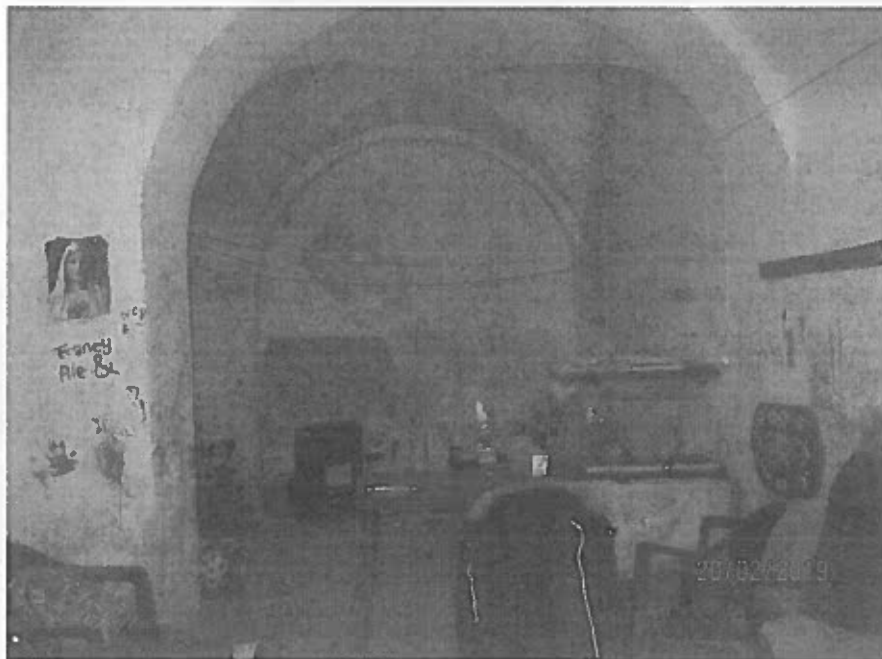
Vano 1 - (locale piano terra)
