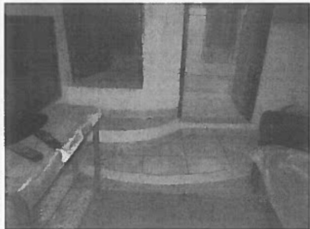
Vano 5 - (servizio igienico)
