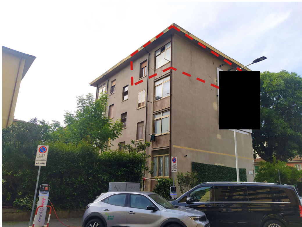
FOTO 3 Vista dalla Via Orazio Vecchi – fianco sinistro e facciata posteriore (Nord)
