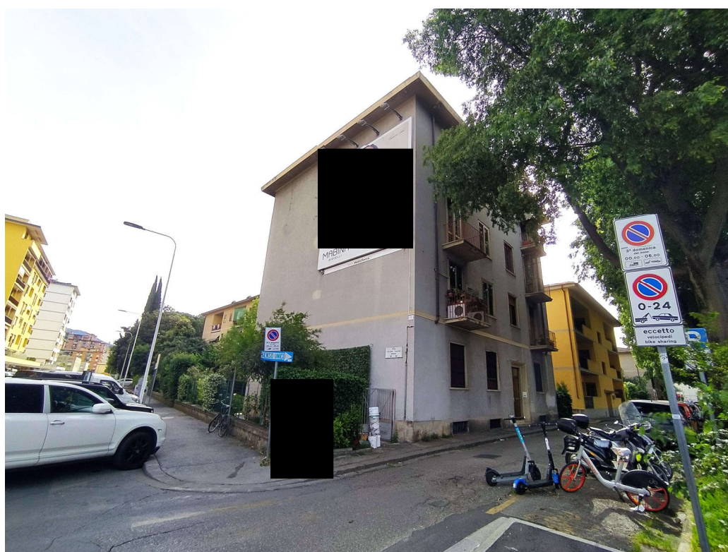
FOTO 2 vista dalla strada fianco sinistro
