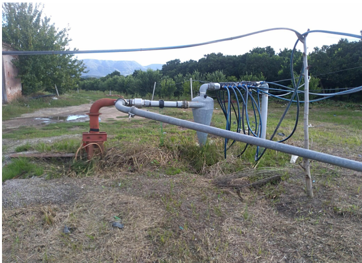
Pompa di tiraggio e tubazioni di distribuzione
