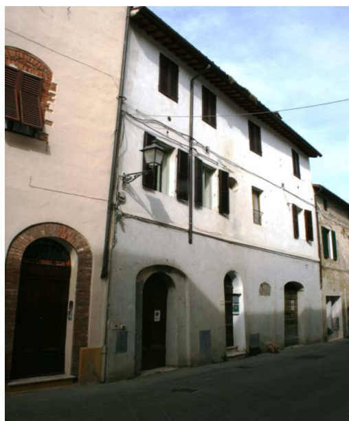
Veduta esterna palazzo Corso Matteotti
