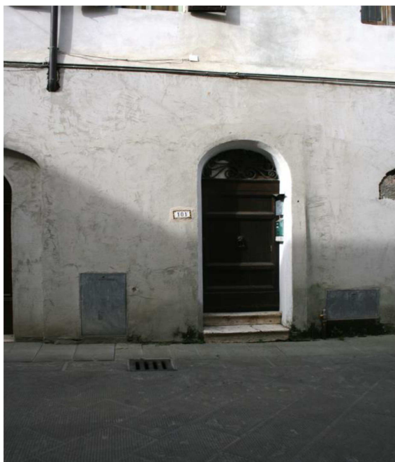
Portone ingresso del palazzo Corso Matteotti
