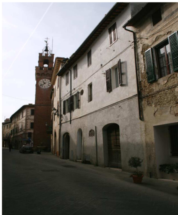
Veduta esterna palazzo Corso Matteotti
