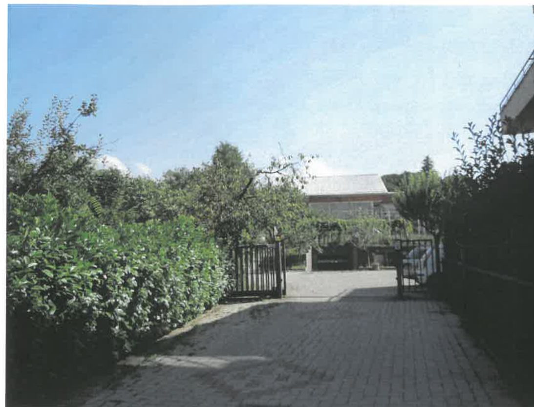
Foto 1 - Cannello ingresso cespiti A, B, C, D e F
