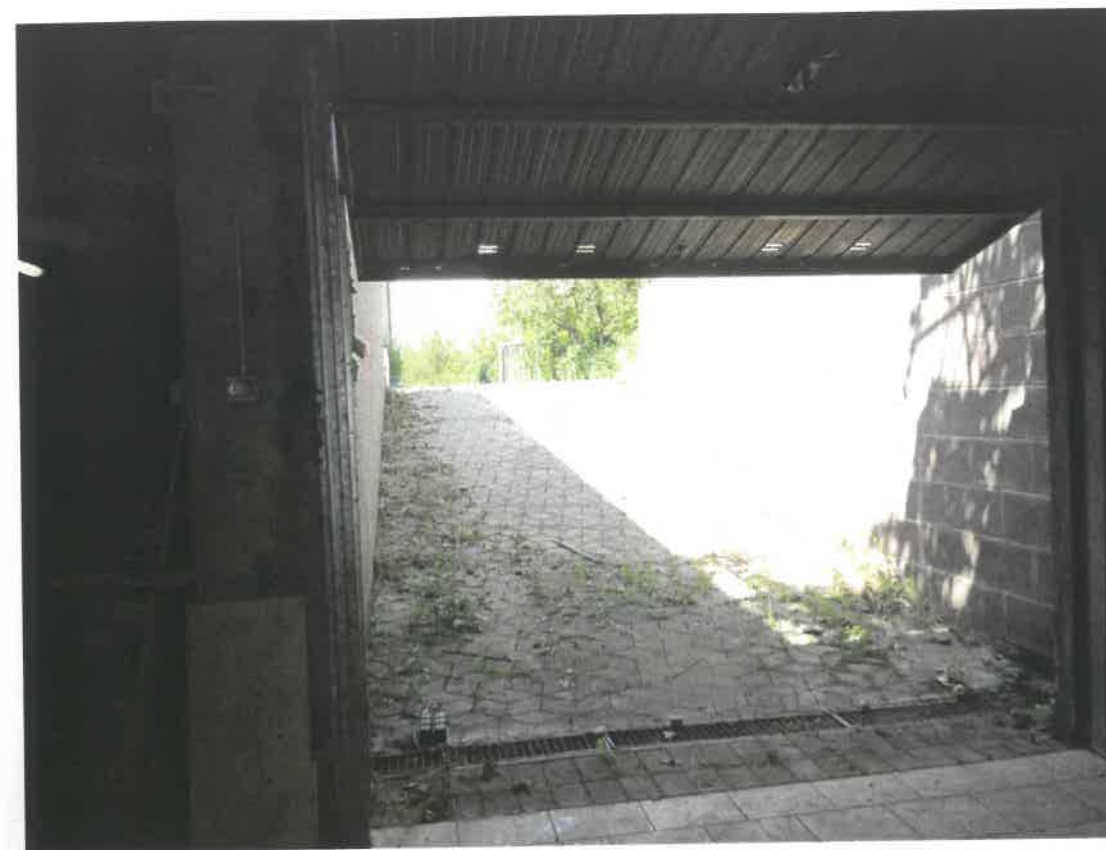
Foto 29 – Interno garage interrato cespite F
