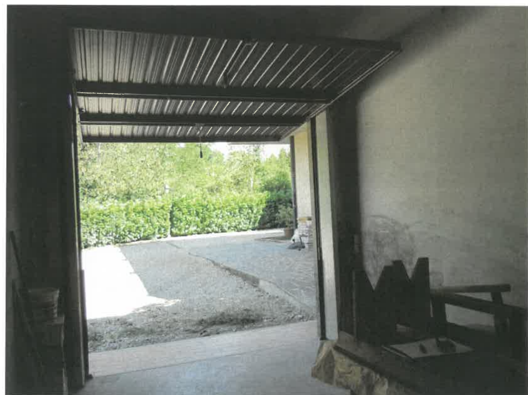
Foto 28 – Interno garage cespite E
