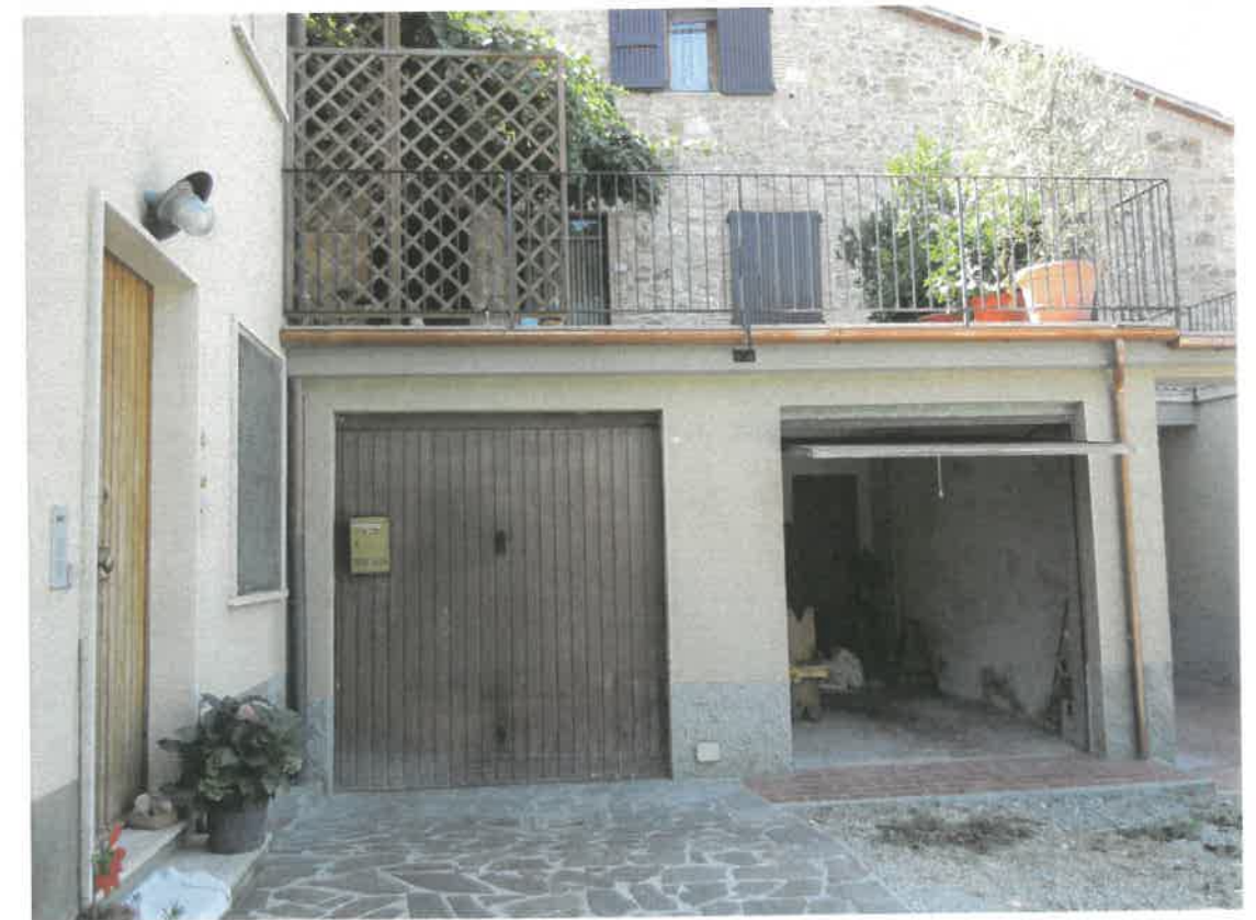
Foto 26 – Esterno garage cespite E
