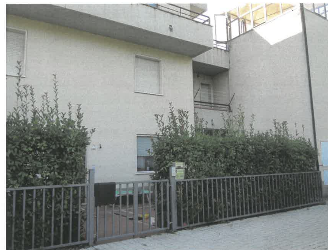
Foto 5 – Ingresso resede esterno cespite A
