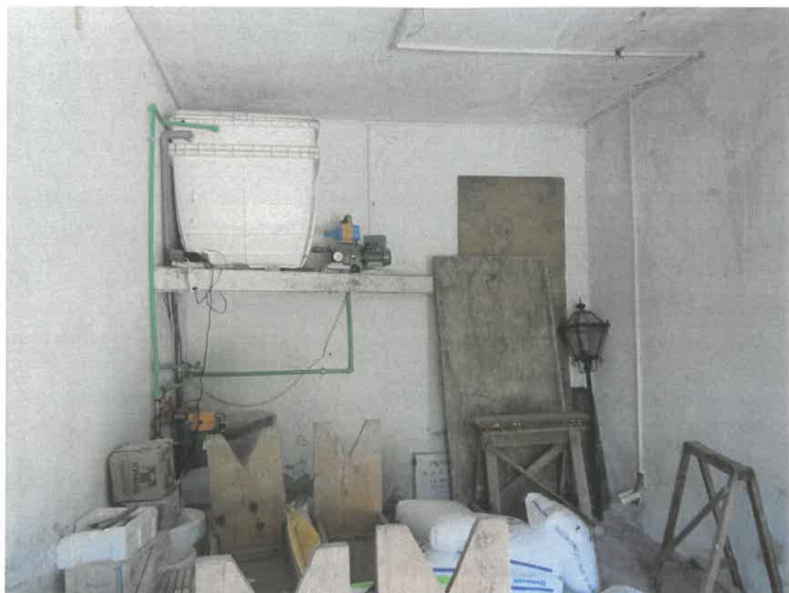
Foto 27 – Interno garage cespite E
