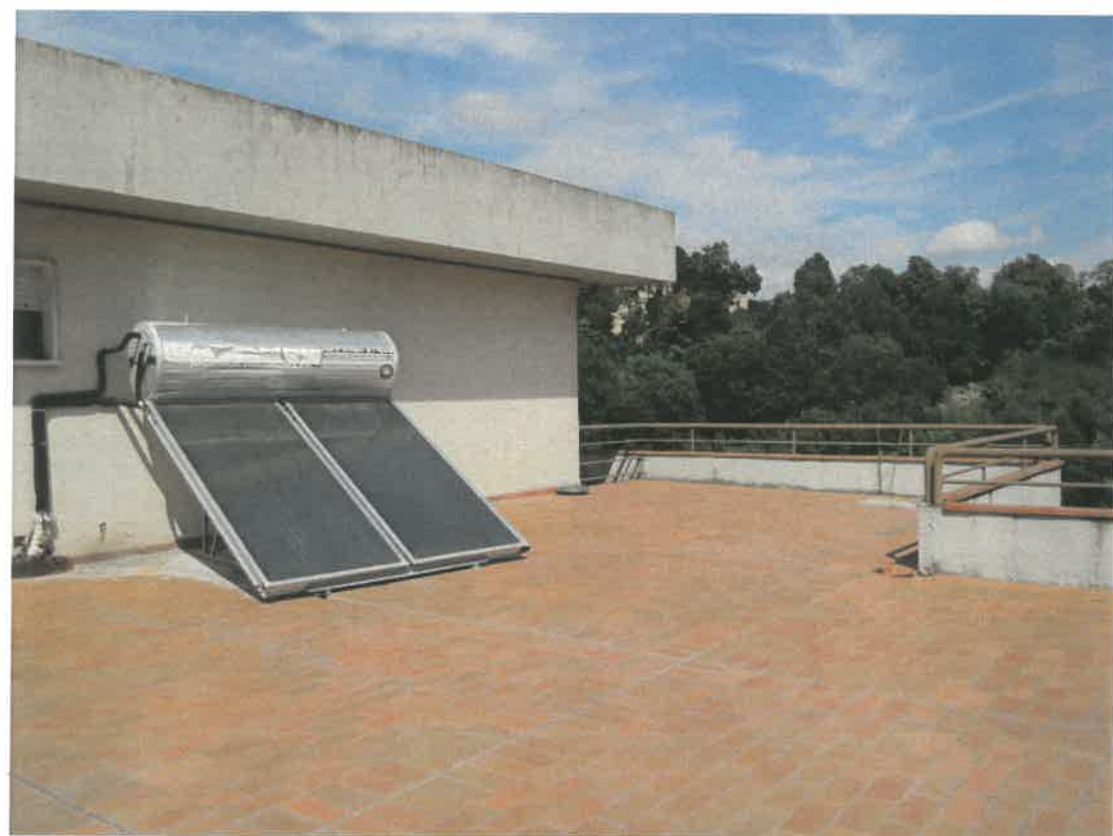
Foto 20 – Lastrico solare/terrazzo con pannello fotovoltaico cespite B
