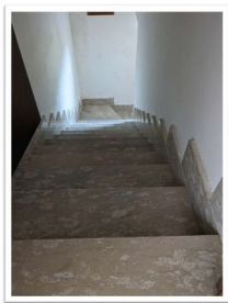
SCALA INTERNA CHE COLLEGA IL PIANO RIALZATO AL PIANO INTERRATO
