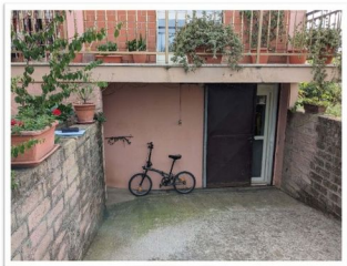
ACCESSO AL PIANO INTERRATO
