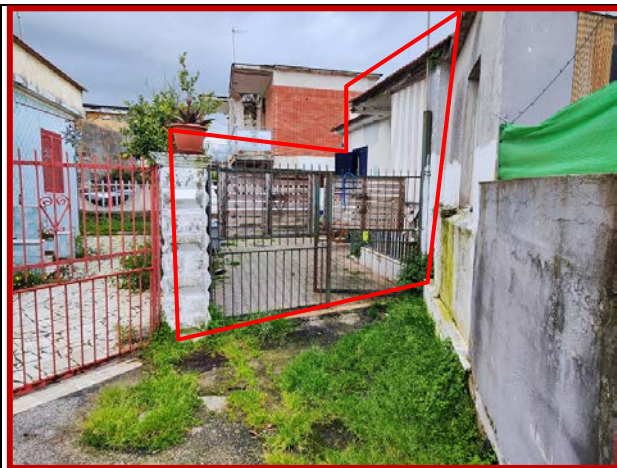
Vista del fabbricato dalla traversa
