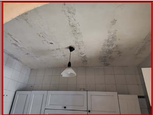
Vista soffitto cucina
