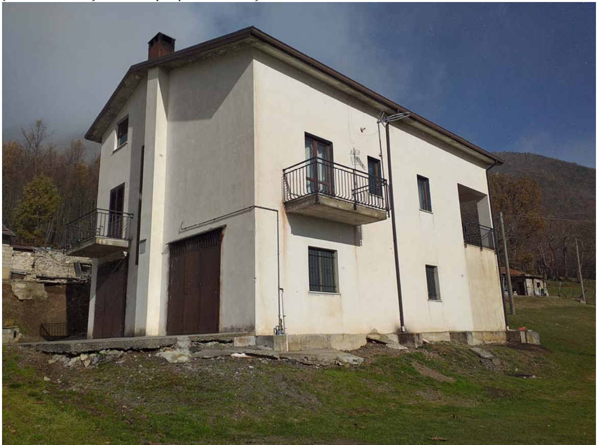
(Vista esterna del fabbricato - prospetto sud-ovest)
