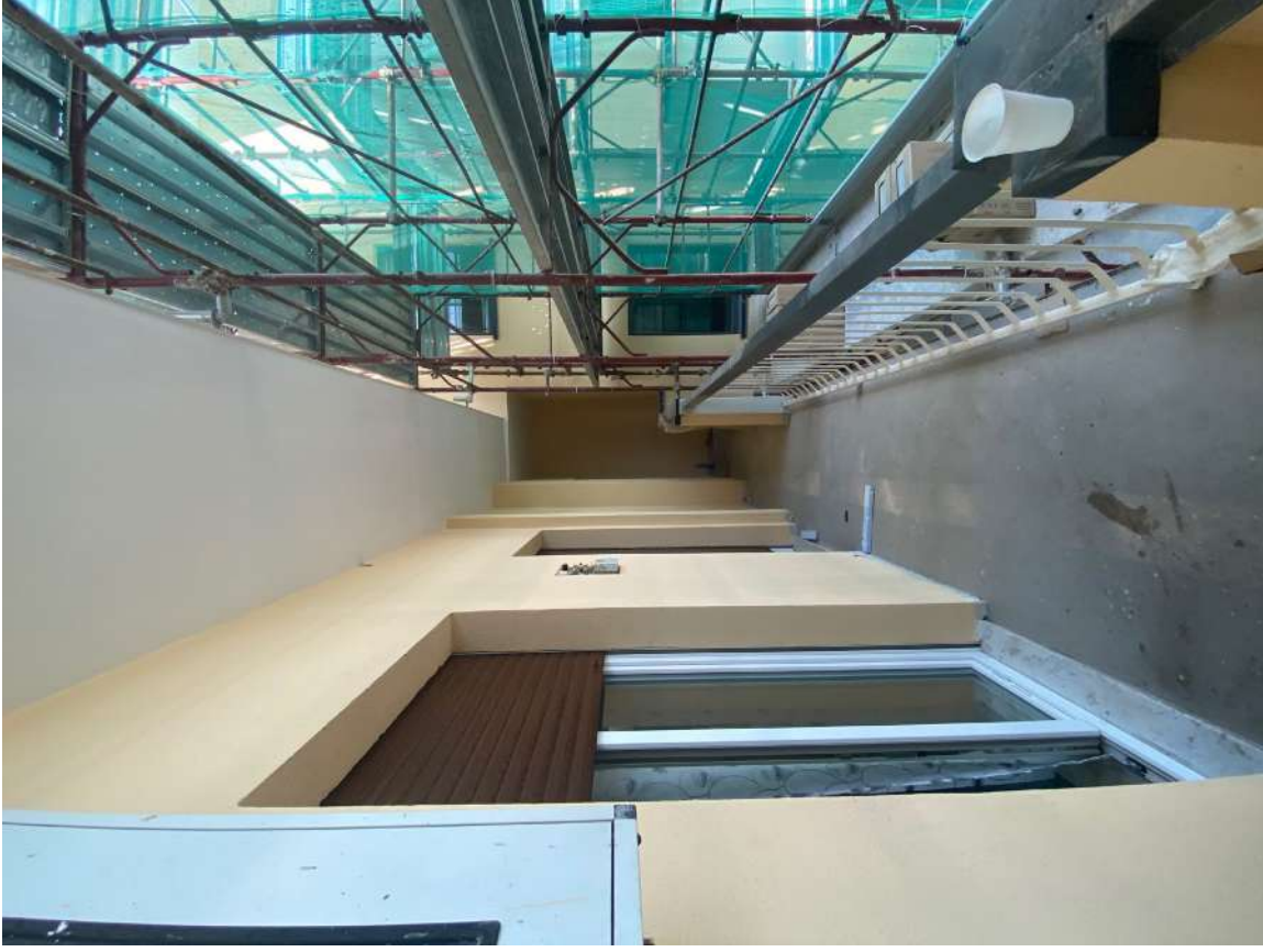
Foto n. 31: Balcone fronte nord
