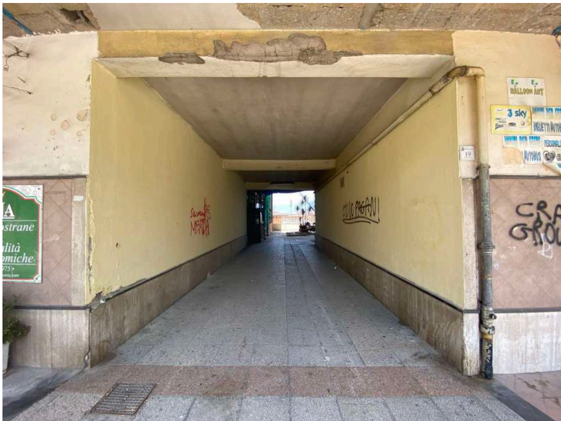
Foto n. 8: Accesso alla corte del fabbricato dal civico 19 di Via Aniello Califano
