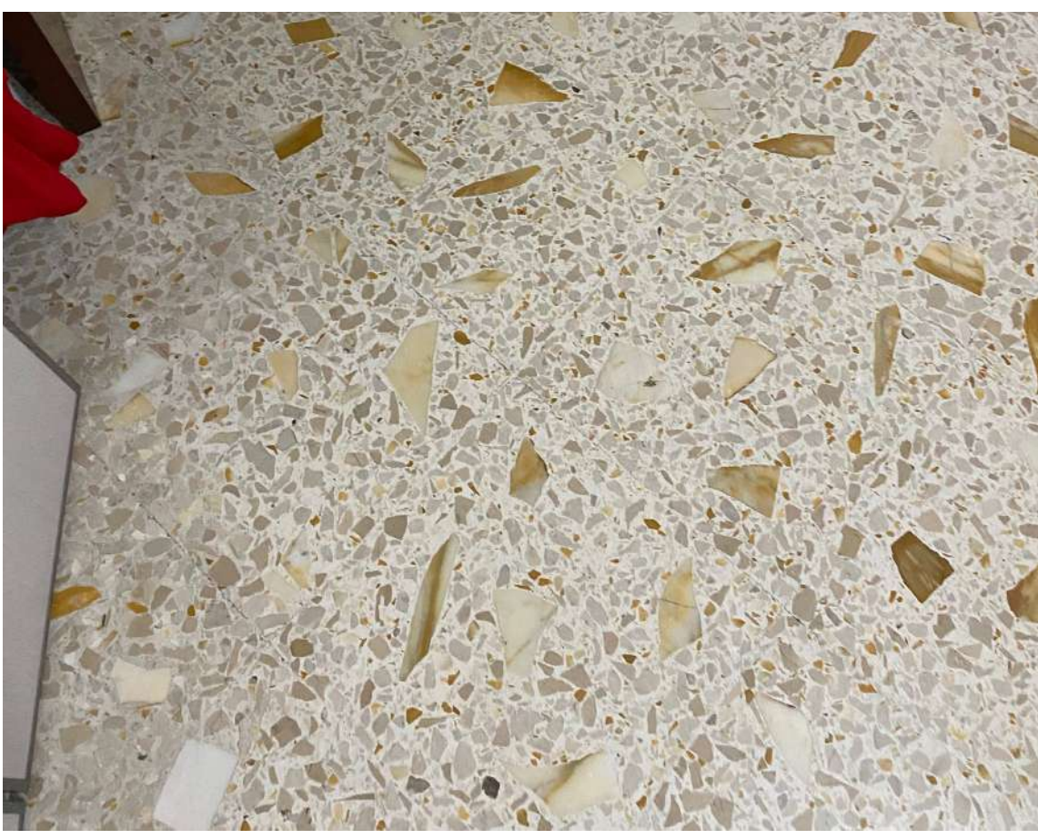
Foto n. 28: Pavimento interno in segato di marmo
