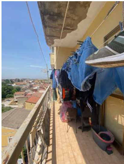
Foto n. 13: Balcone a sud su Via Califano
