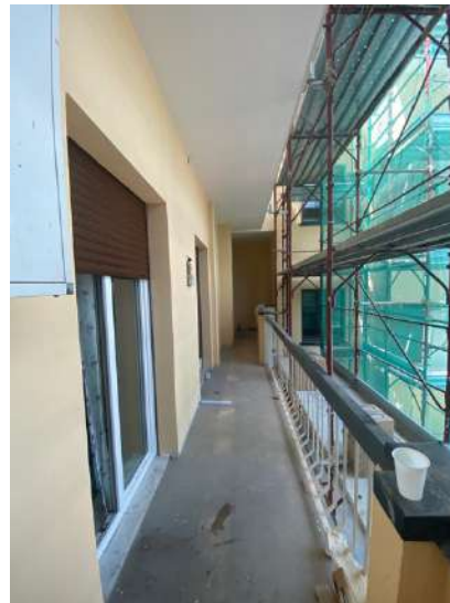
Foto n. 15: Balcone fronte nord
