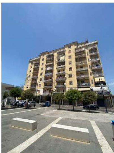
Foto n. 4: Palazzo "Sorrentino" su Via A. Califano, 19 a S. Egidio del Monte Albino
