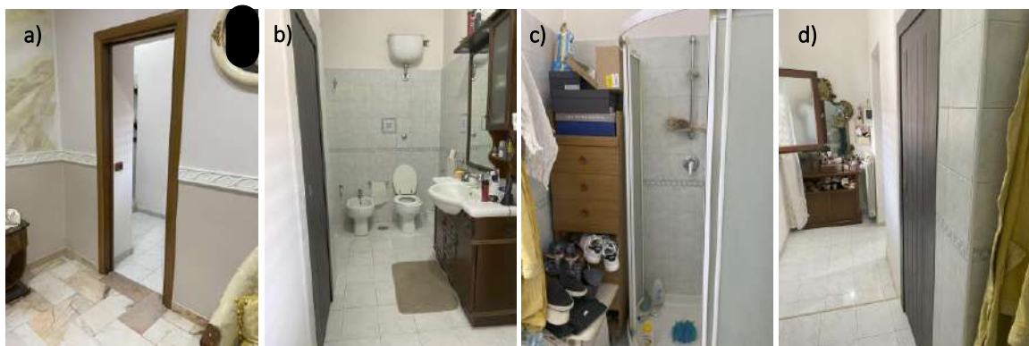
Figura 14: a) accesso al bagno 2; b), c), d) bagno 2
