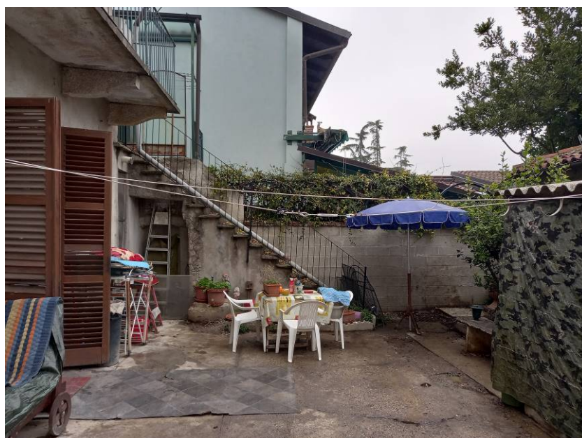
Vista cortile esclusivo e lato interessato da scrittura privata
