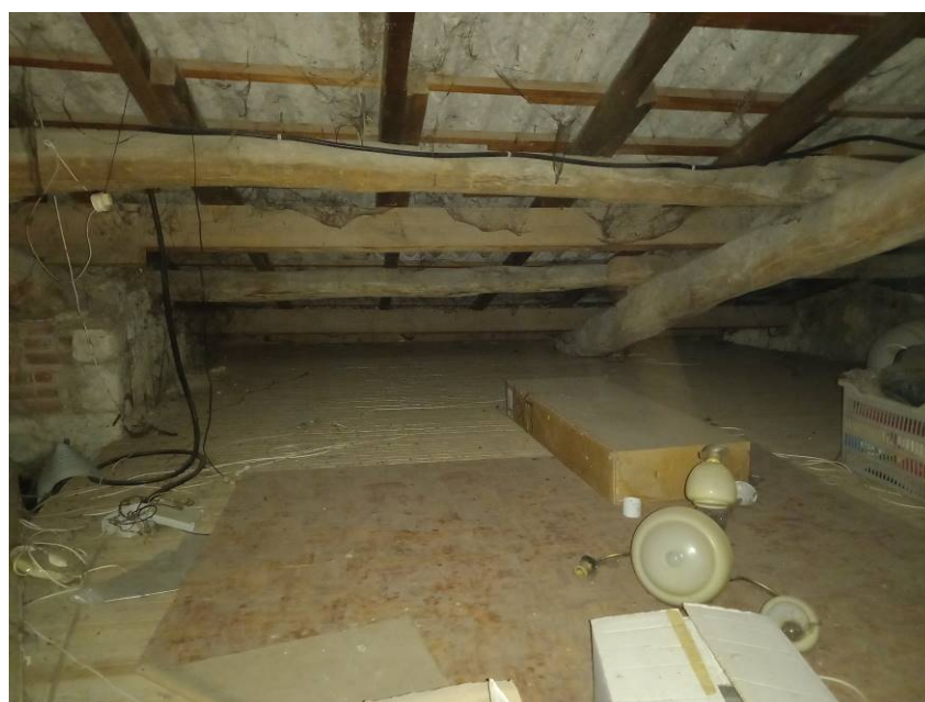
Piano Secondo – Locale Sottotetto 1 con lastre di copertura di cui al Quesito 1
