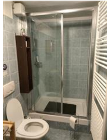
Bagno non autorizzato al piano interrato.
