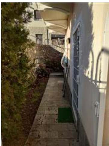
Passaggio pedonale lungo il fronte ovest del fabbricato.
