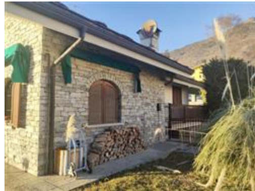
Fronte est del fabbricato.
