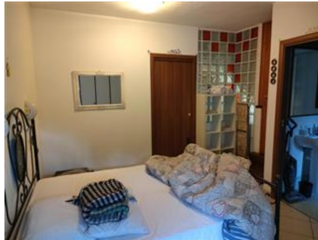
Partizione verticale interna realizzata al piano terreno in difformità a quanto riportato sugli elaborati progettuali..
