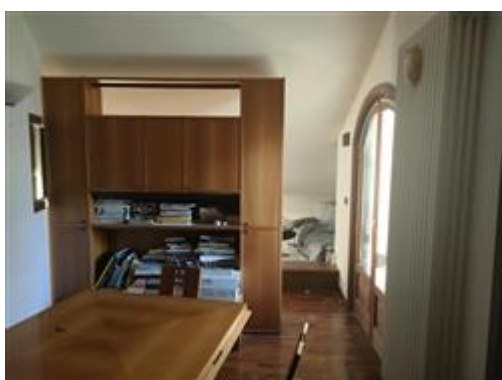
Assenza della partizione verticale interna che delimita la porzione non abitabile del sottotetto.
