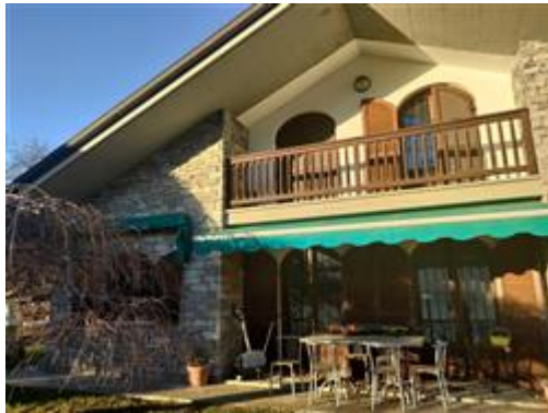
Fronte sud del fabbricato.
