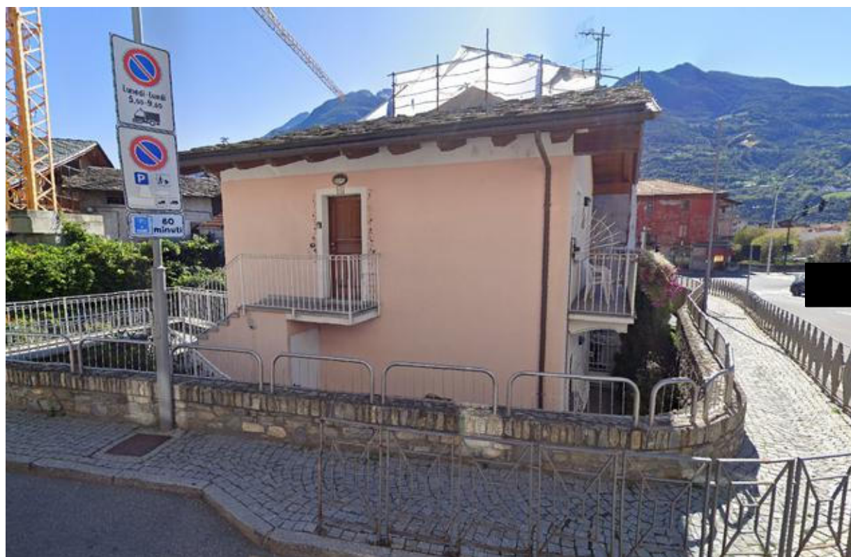
Illustrazione 2: Fronte nord del fabbricato oggetto di esecuzione immobiliare censito al catasto fabbricati del comune di Aosta al foglio 60 n. 572 sub. 3. Vista della scala esterna e del portone di ingresso al piano primo.
