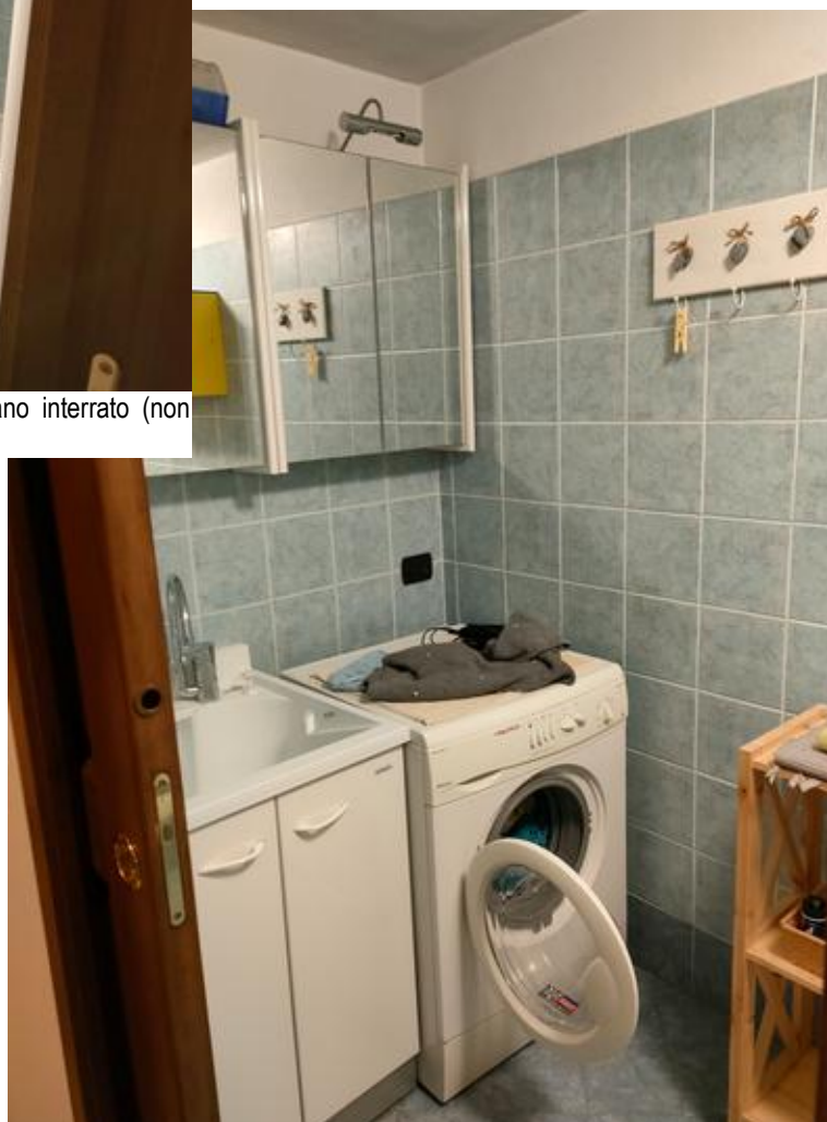
Illustrazione 27: Piano interrato - Bagno ricavato al piano interrato (non autorizzato).
