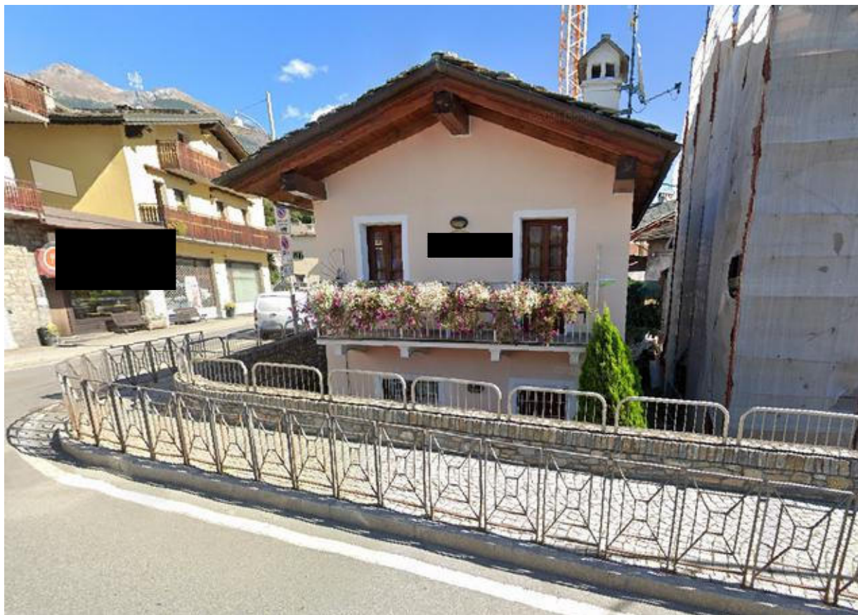
Illustrazione 1: Fronte ovest del fabbricato oggetto di esecuzione immobiliare censito al catasto fabbricati del comune di Aosta al foglio 60 n. 572 sub. 3.
