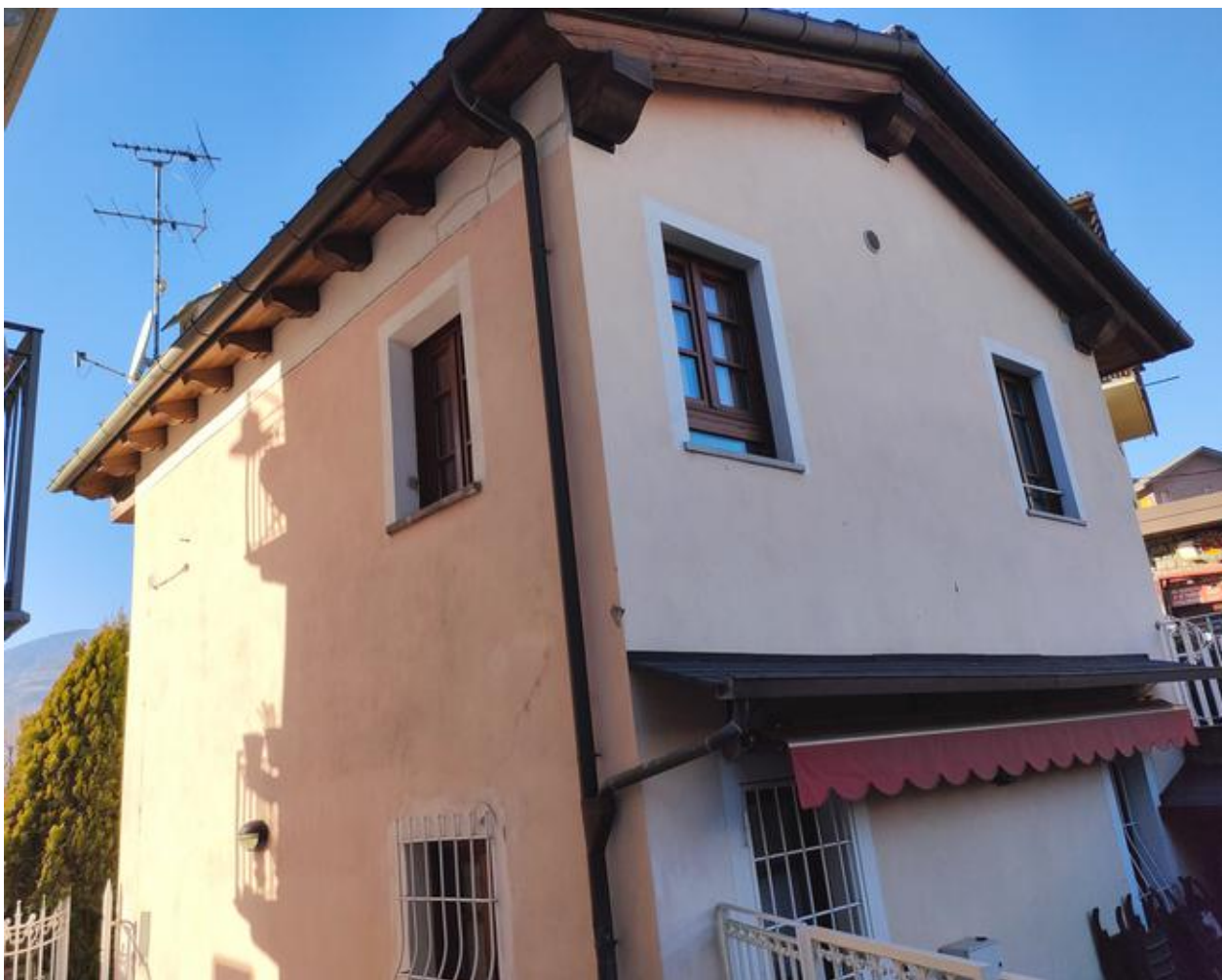
Illustrazione 3: Fronti sud ed est del fabbricato oggetto di esecuzione immobiliare censito al catasto fabbricati del comune di Aosta al foglio n. 572 sub. 3.
