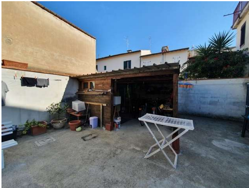
Manufatto in Legno edificato senza autorizzazione
