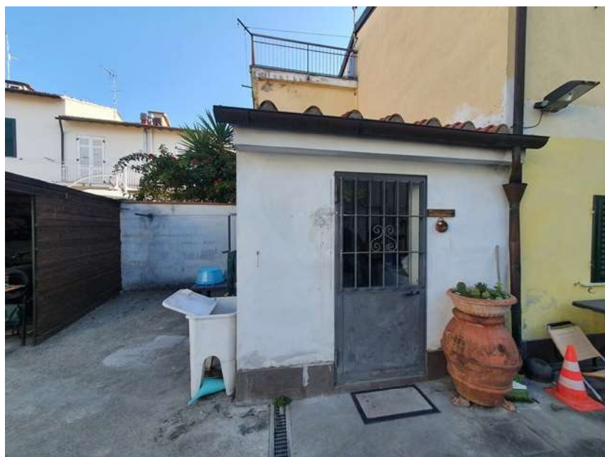
Locale ad uso Lavanderia a servizio del LOTTO 1
