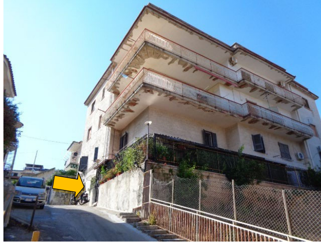
Veduta esterna del fabbricato da Traversa di Via S. Croce Vecchia
