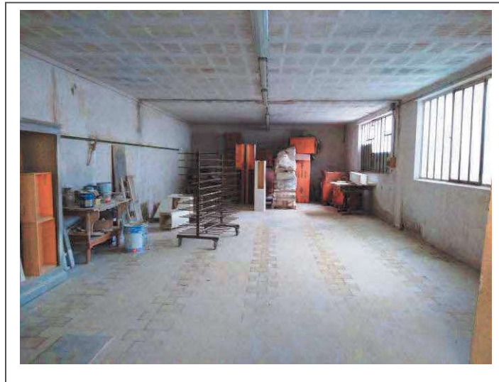
FOTO N. 20 - Locale seminterrato lato vecchio
