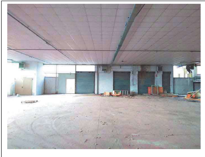
FOTO N. 7 - Interno fabbricato lato nord
