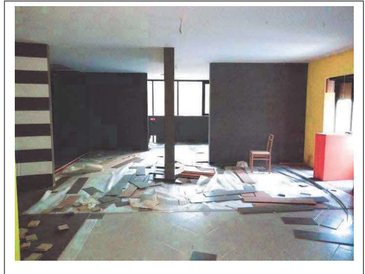
FOTO N. 16 - Interno uffici al P1
