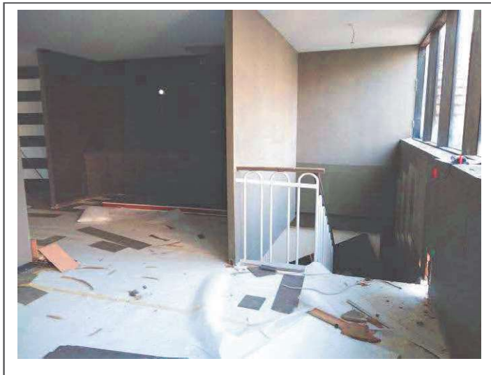
FOTO N. 15 - Uffici piano primo e scala al PT
