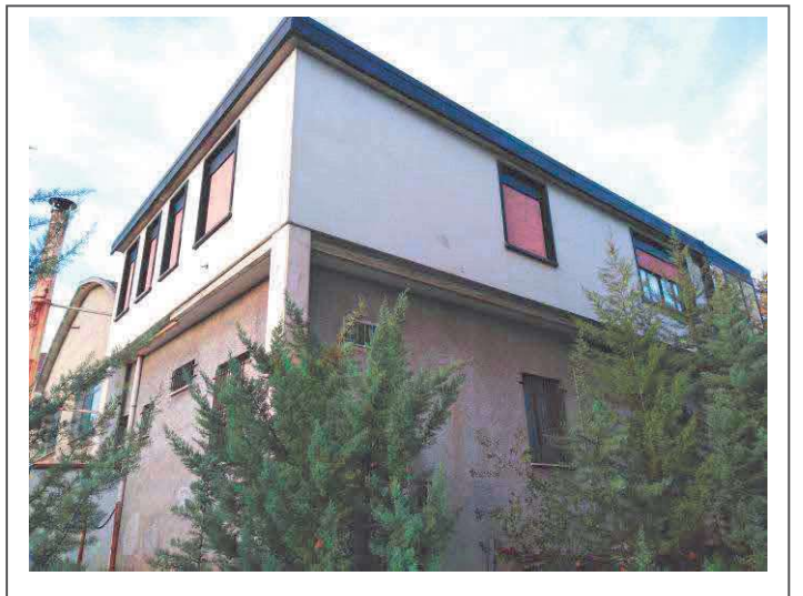
FOTO N. 4 - Fronte sud-ovest, palazzina uffici
