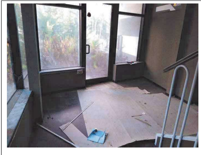
FOTO N. 13 - Ingresso palazzina uffici
