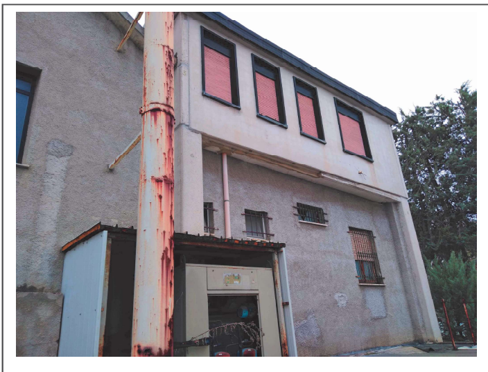
FOTO N. 21- Fronte ovest zona uffici
