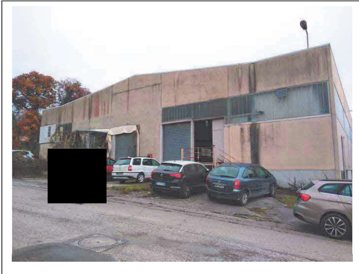
FOTO N. 1 - Fronte del fabbricato lato nord
