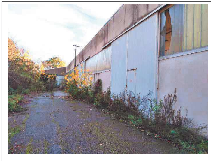
FOTO N. 3 - Fronte del fabbricato lato est
