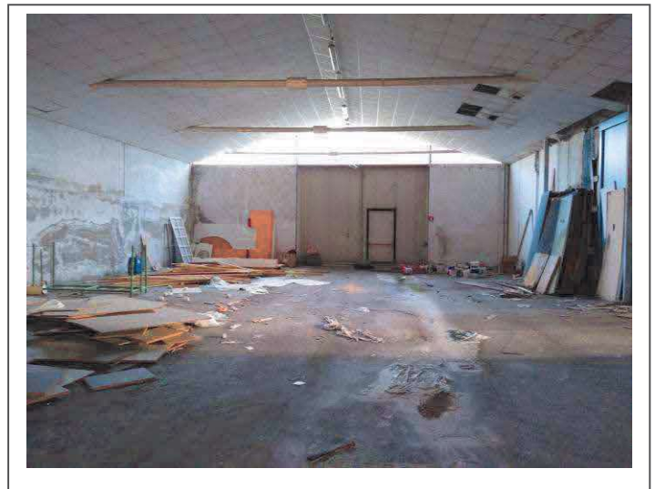
FOTO N. 10 - Interno locale sud-est
