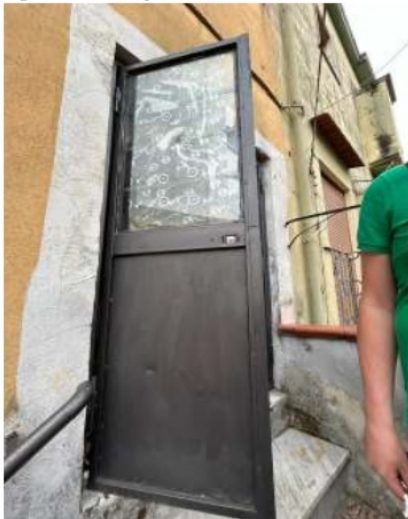
Ingresso secondo piano
