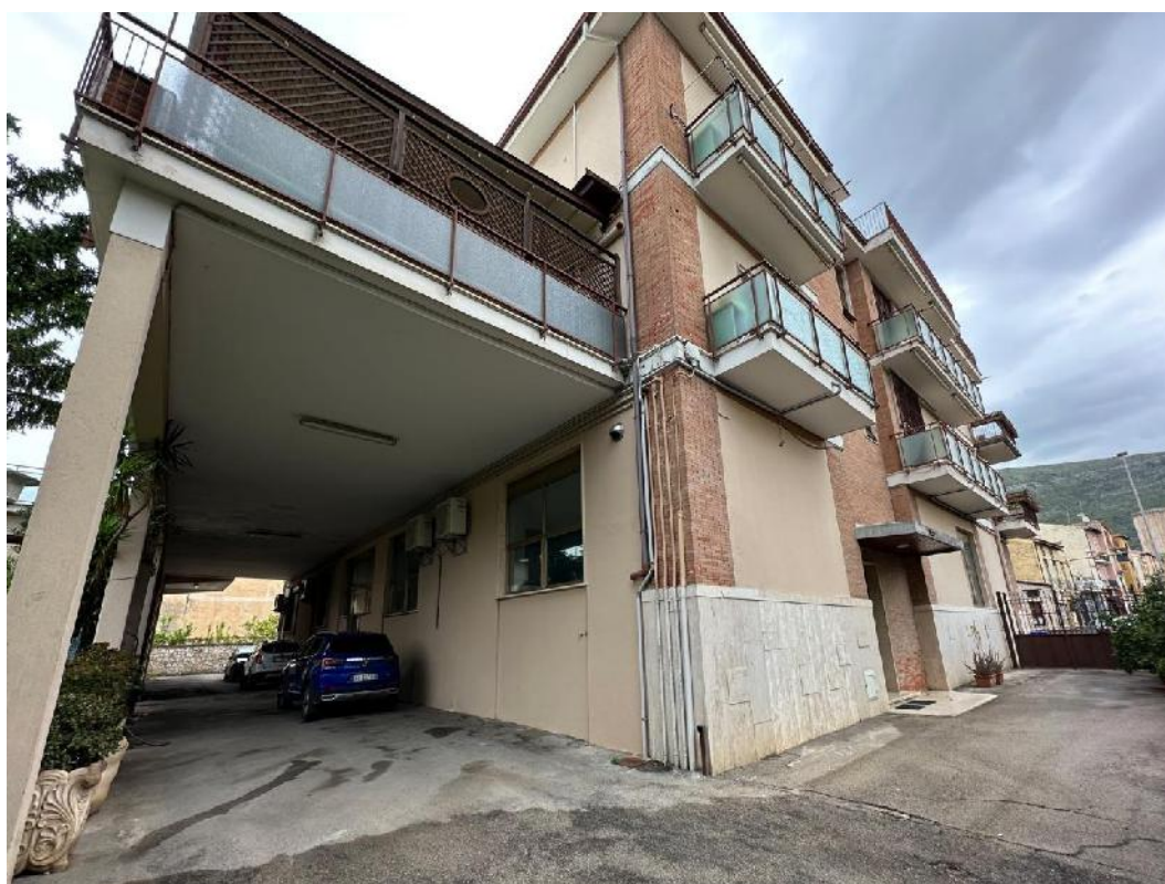
FOTO n. 2 - Panoramica esterna Lotto n. 1 - 2 - 3 Via Spinete
