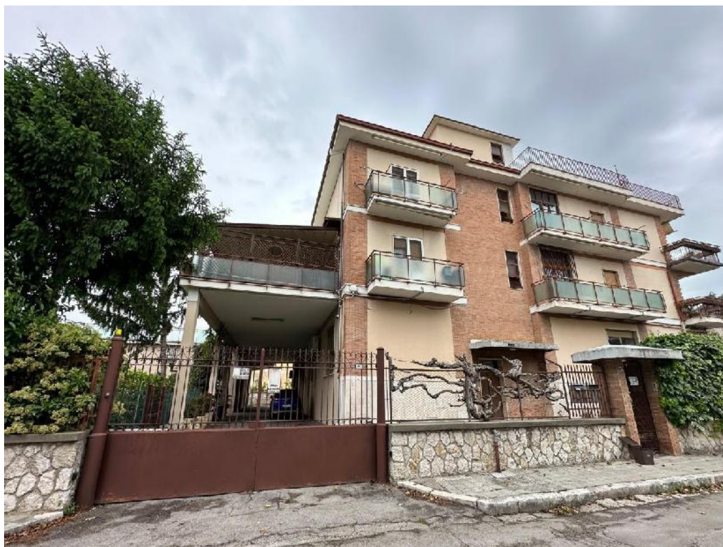
FOTO n. 1 - Panoramica esterna Lotto n. 1 - 2 - 3 Via Spinete
