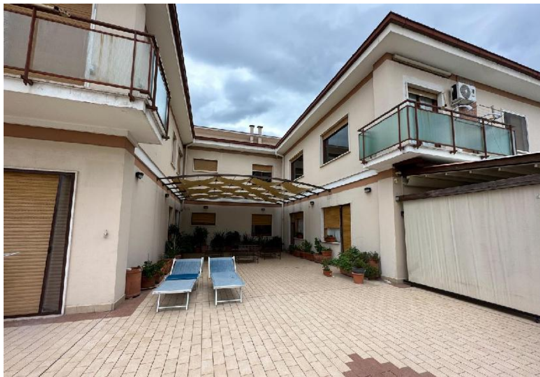
FOTO n. 21 - Panoramica interna Lotto n. 1
