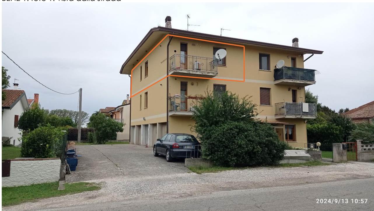
BENE 1: foto 1: vista dalla strada
