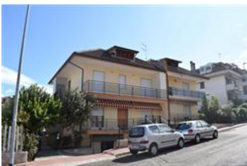
Vista del fabbricato da via Ancona
