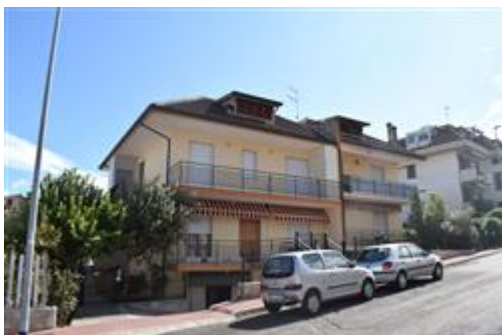
Vista del fabbricato da via Ancona
