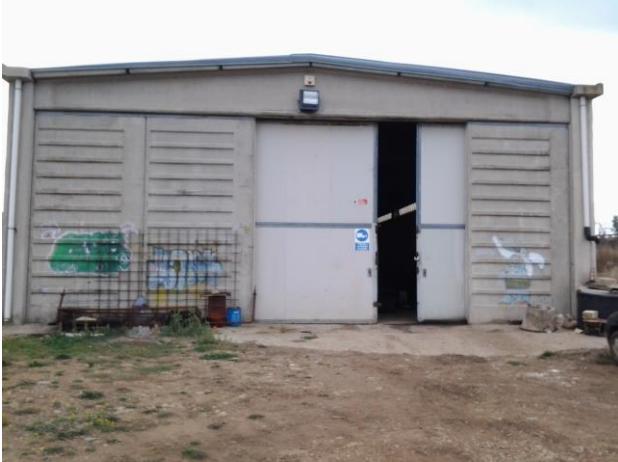
Foto esterna capannone agricolo
