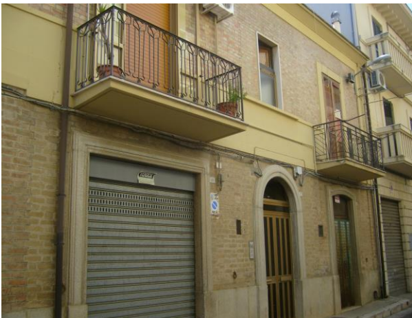
Foto esterna Via A. Barrile
