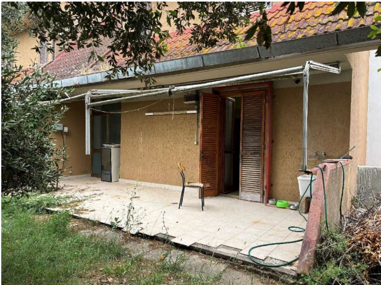
Portico retro a piano terra limitrofo alla cucina
