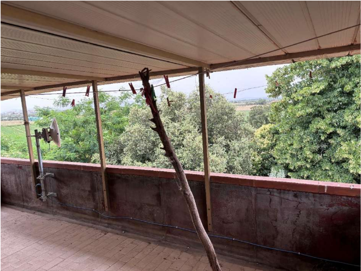
Vista terrazza a tetto con tettoia
