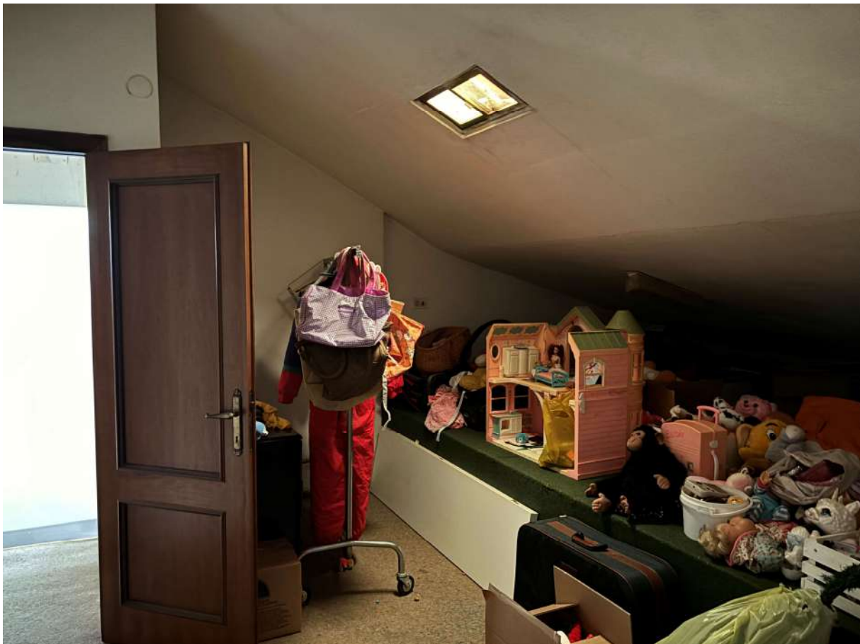
Vista locale lavanderia con lucernario dall'interno
