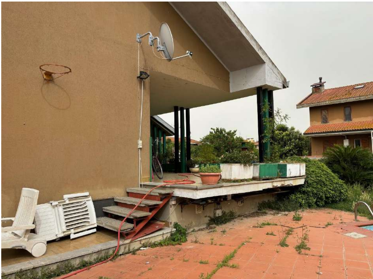
Vista laterale portico esterno
