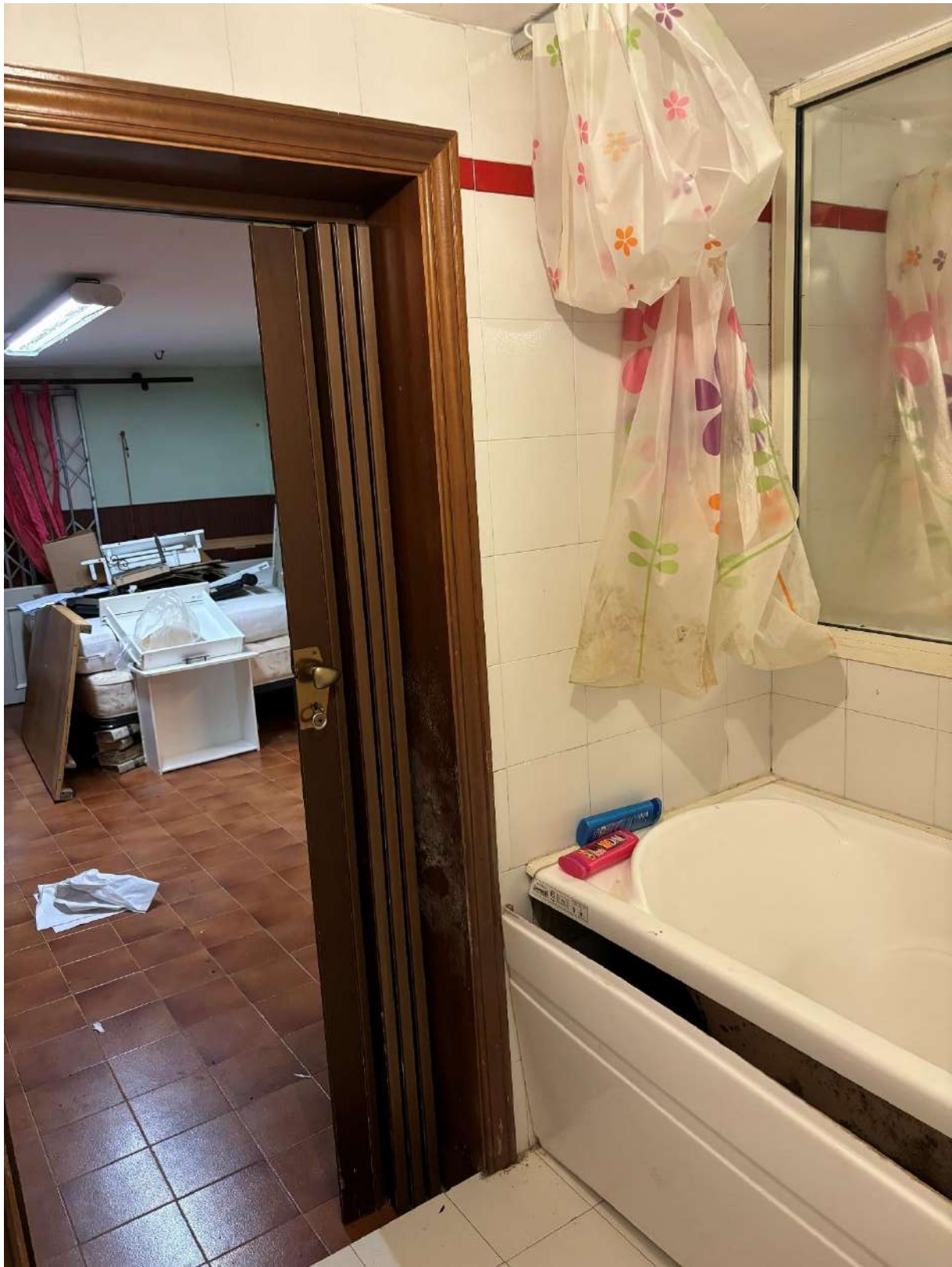
Vista servizio igienico limitrofo autorimessa
