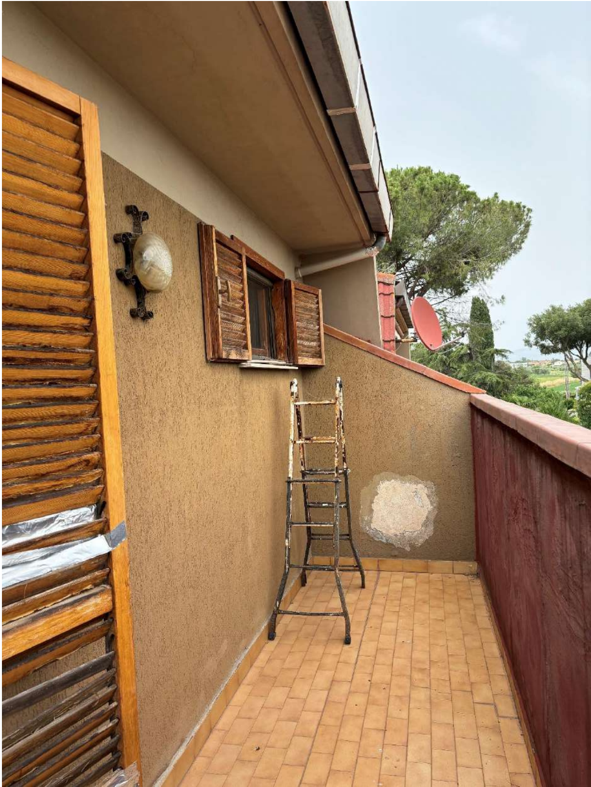
Vista terrazza camera 3 e finestra servizio igienico limitrofo
