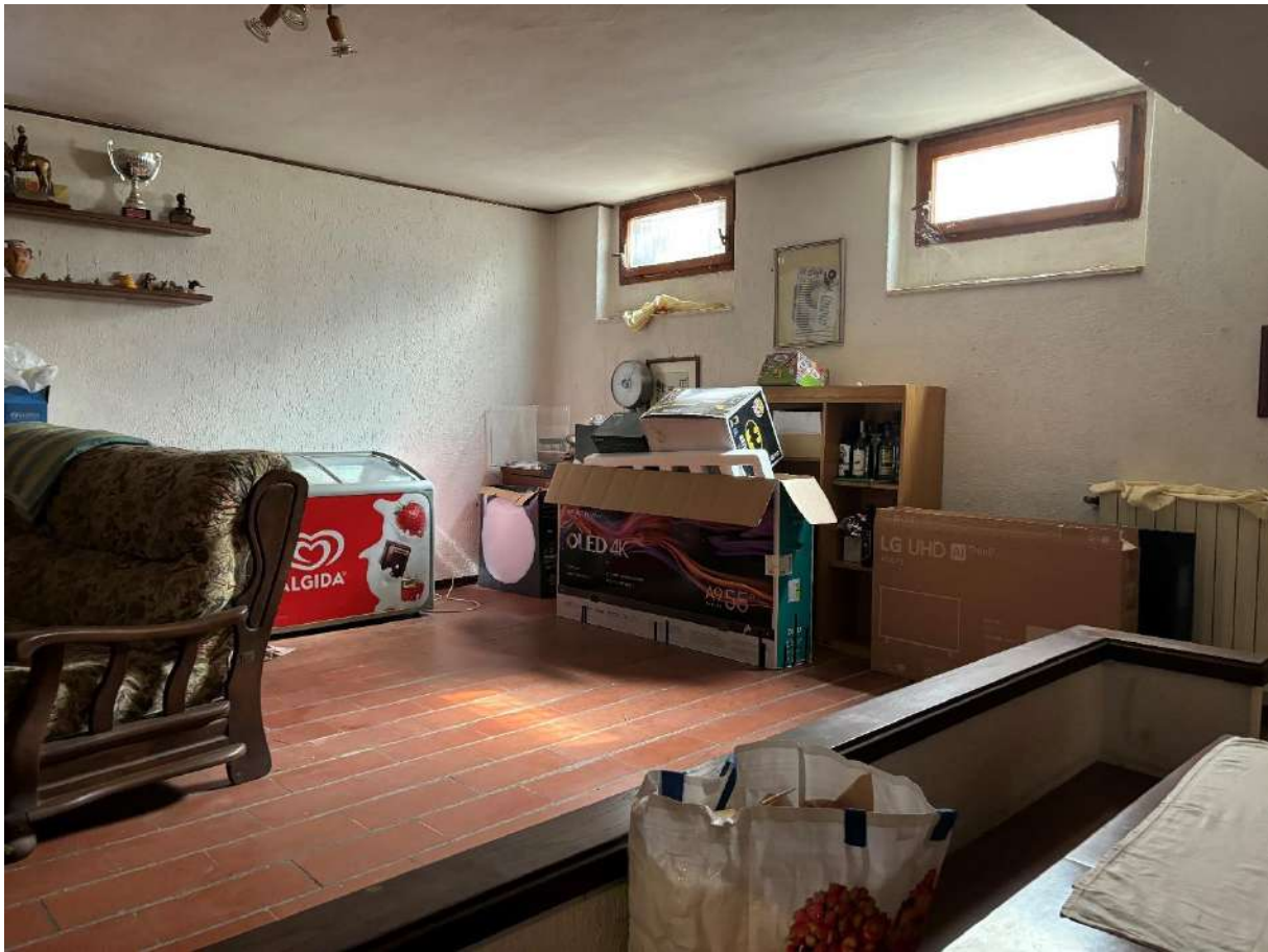
Vista finestre secondo locale cantina
