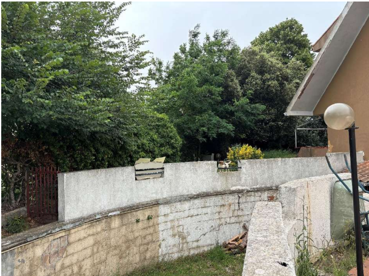
Vista rampa carrabile laterale a piscina per accesso autorimessa
