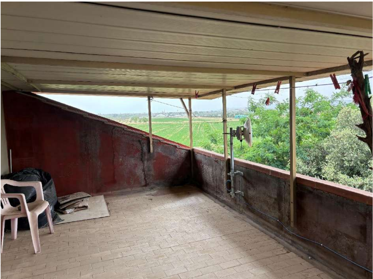
Vista terrazza a tetto con tettoia
