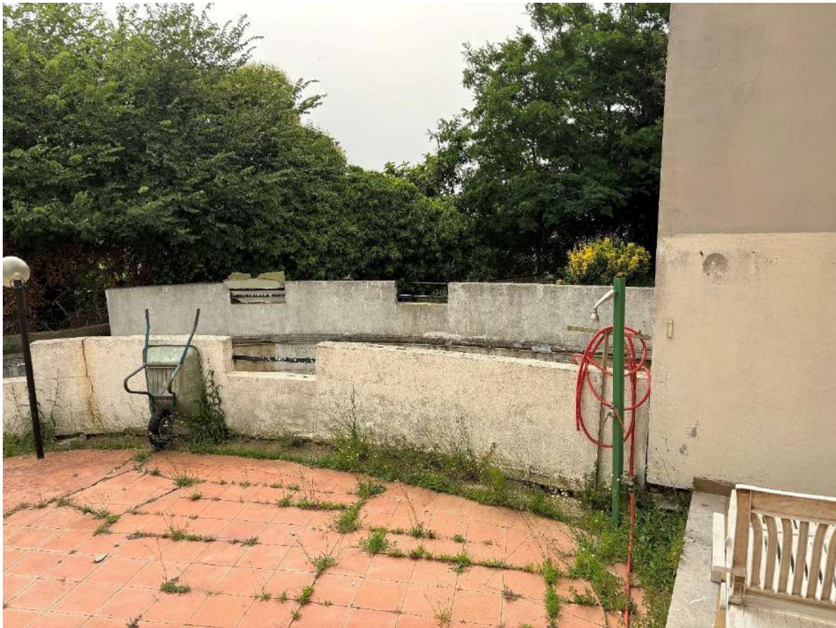
Vista area pavimentata limitrofa piscina e portico
