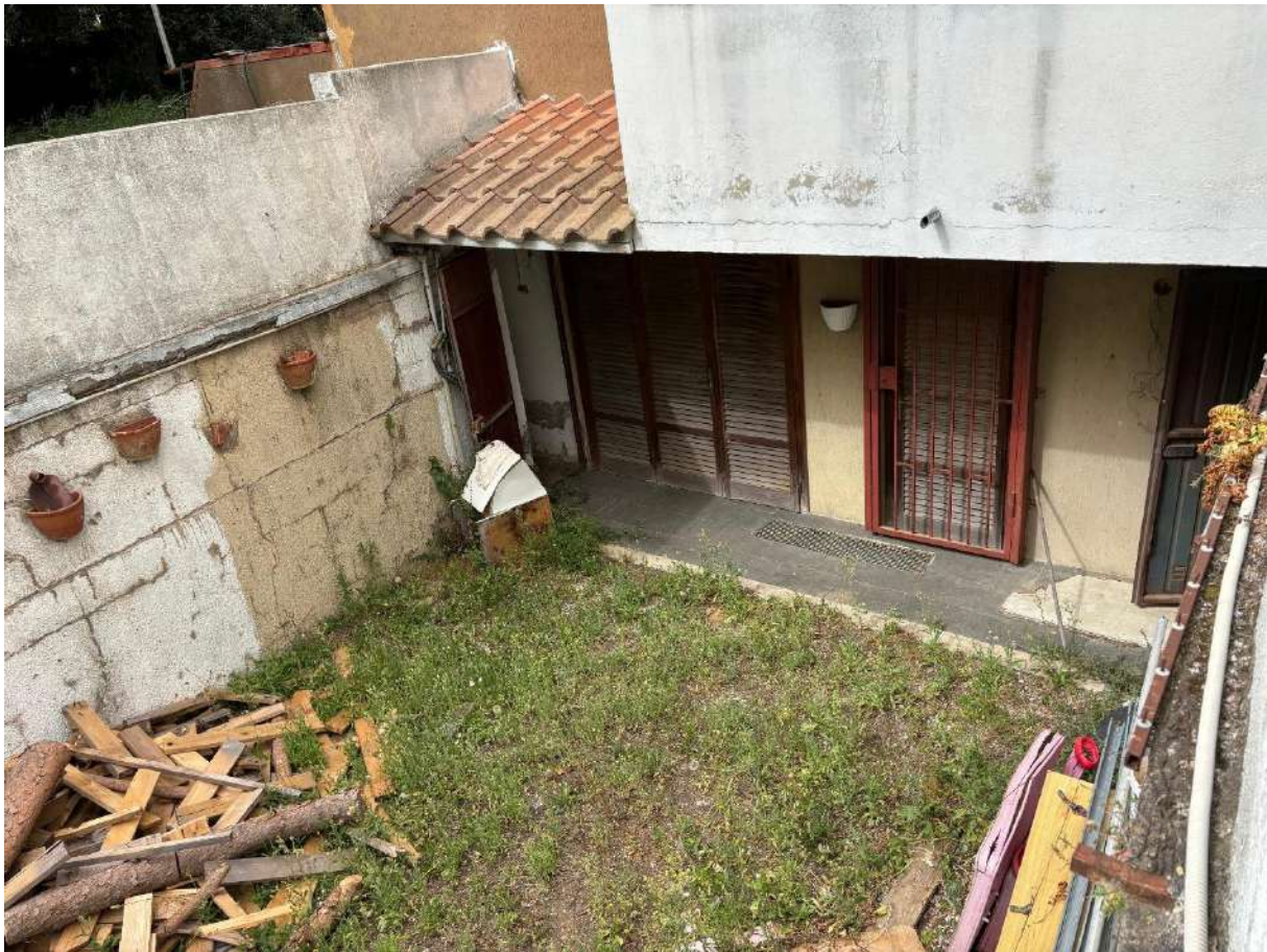
Vista accessi esterni locale seminterrato (sin. autorimessa – dex. cantina)
