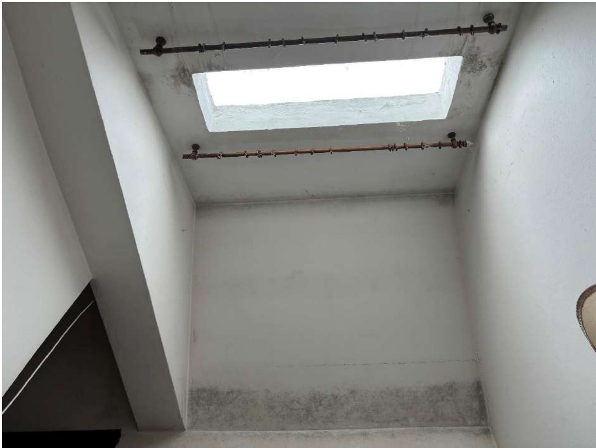
Vista lucernario sulla sommità della rampa scale
