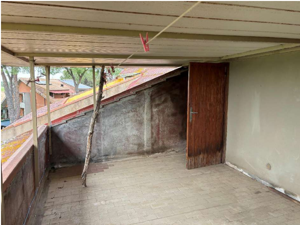
Vista terrazza a tetto con tettoia
