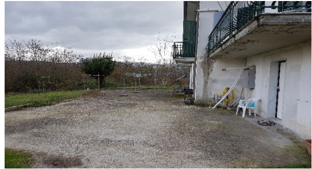
Figura 7 – Vista piazzale retrostante verso EST –
