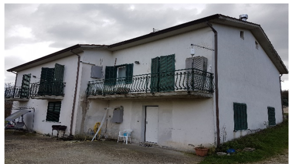
Figura 5 – Vista facciata EST –
