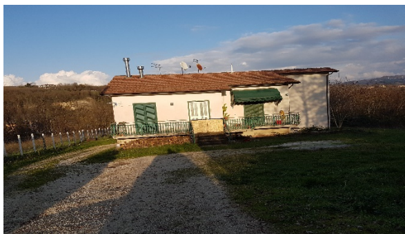
Figura 4 – Vista esterna facciata OVEST–
