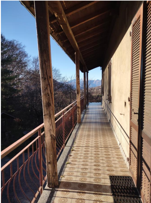
Terrazzo affacciato a sud - ovest
