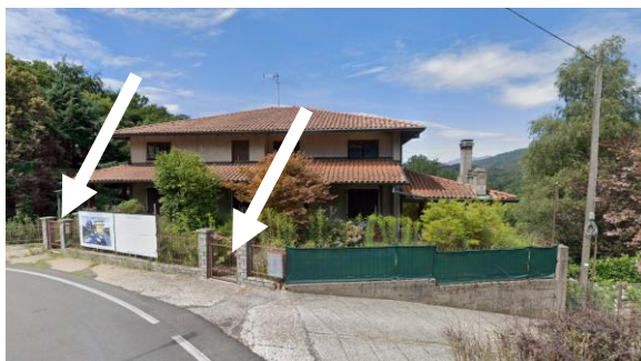
Cancelli pedonali d'ingresso
