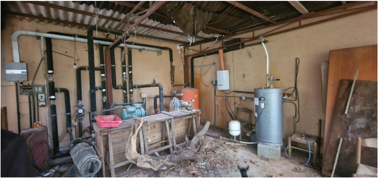
Figura 25 LOCALE TECNICO CON VOLTA COPERTA DA TETTO IN ETERNIT
