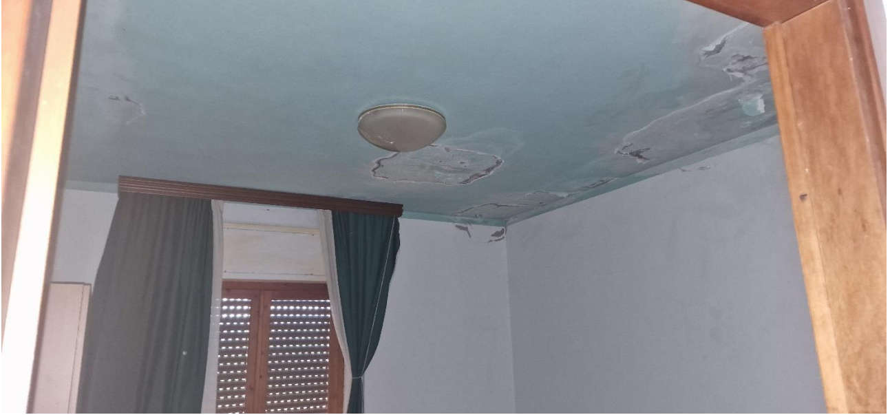
Figura 45 VEDUTA SOFFITTO CAMERA TIPO
