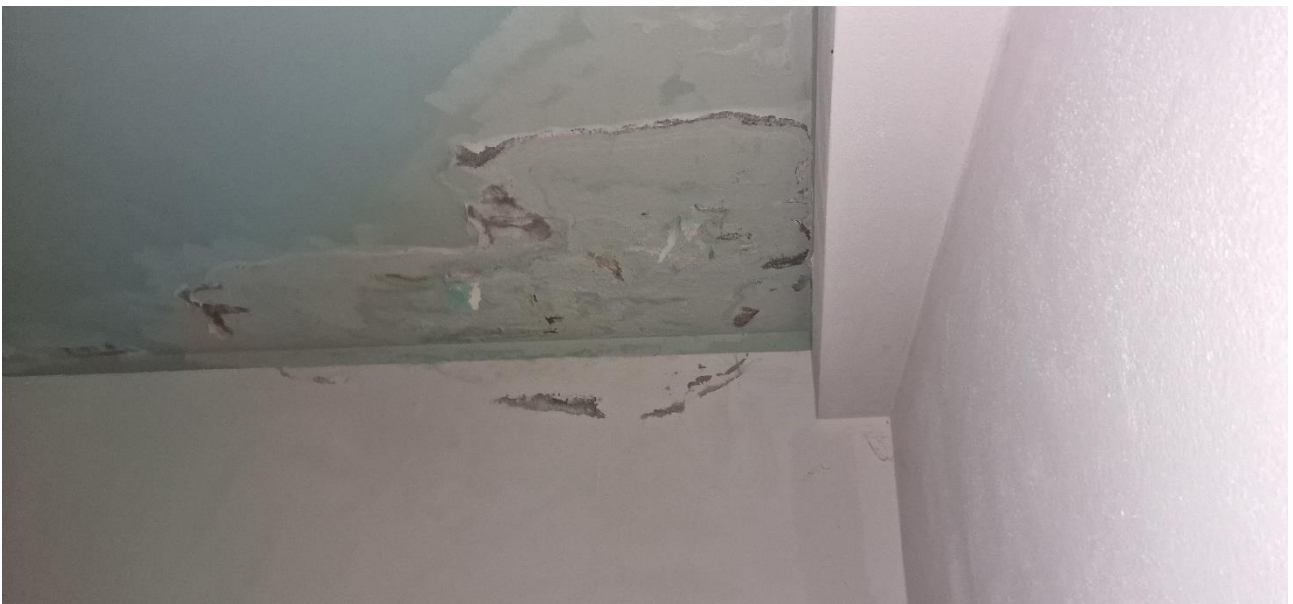
Figura 42 VEDUTA SOFFITTO CAMERA TIPO
