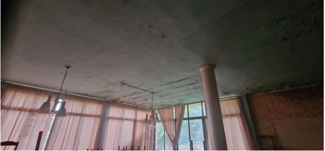
Figura 20 SOFFITTO SALA DA PRANZO
