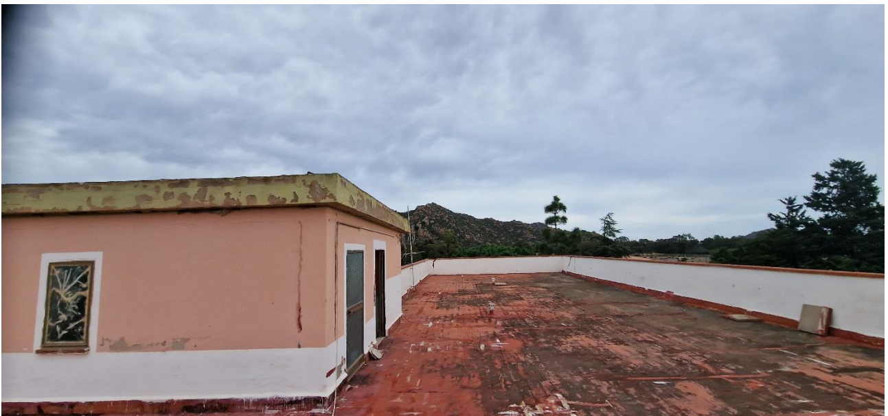
Figura 56 VEDUTA LASTRICO SOLARE
