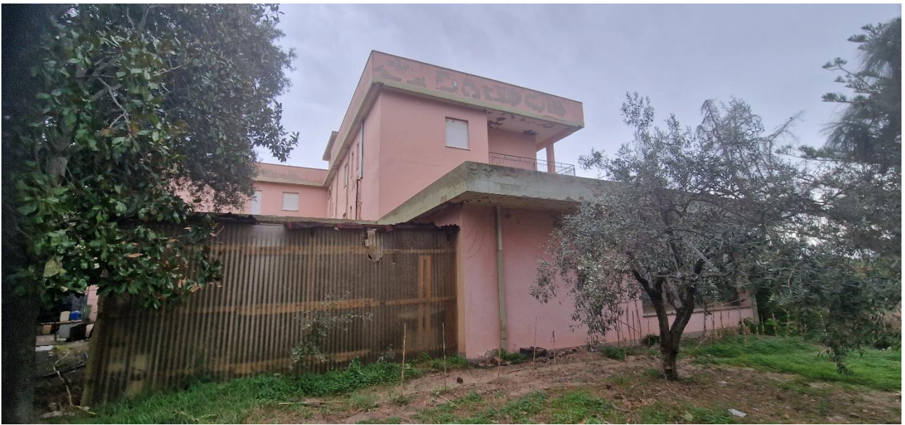
Figura 26 VEDUTA ESTERNA LOCALE TECNICO
