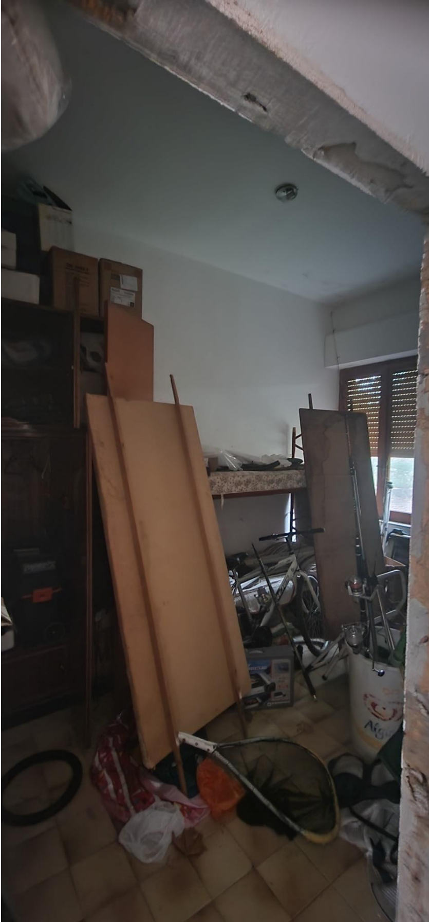
Figura 21 AMBIENTE UTILIZZATO COME DEPOSITO MATERIALE DI SGOMBERO
