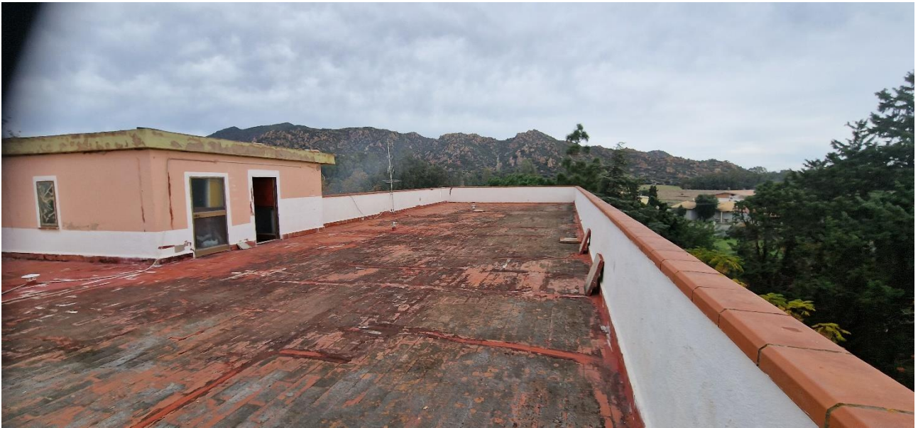
Figura 53 VEDUTA LASTRICO SOLARE
