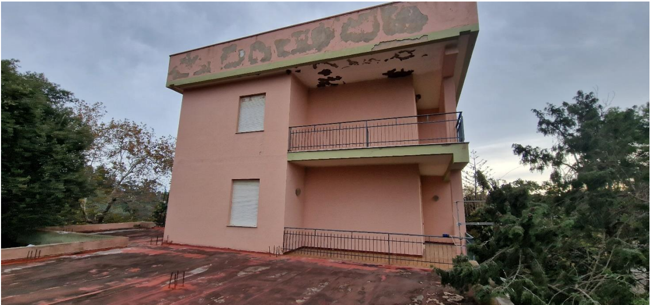
Figura 35 VEDUTA LASTRICO SOLARE SOPRA PIANO TERRA
