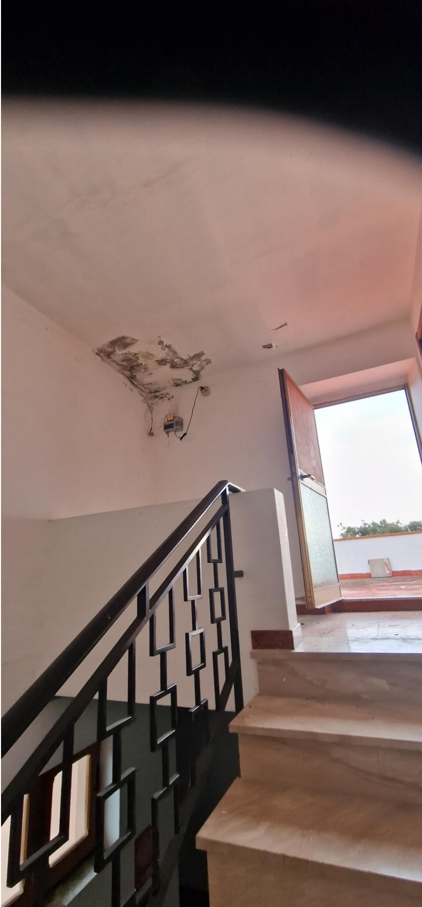
Figura 52 ACCESSO LASTRICO SOLARE HOTEL
