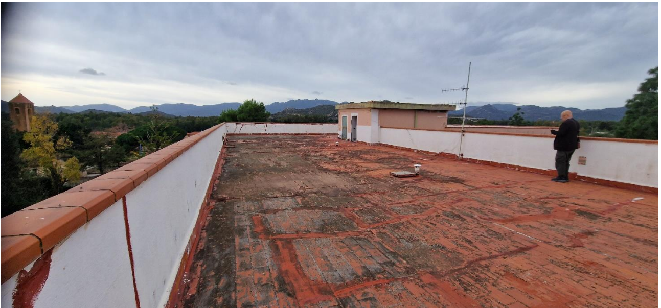
Figura 54 VEDUTA LASTRICO SOLARE
