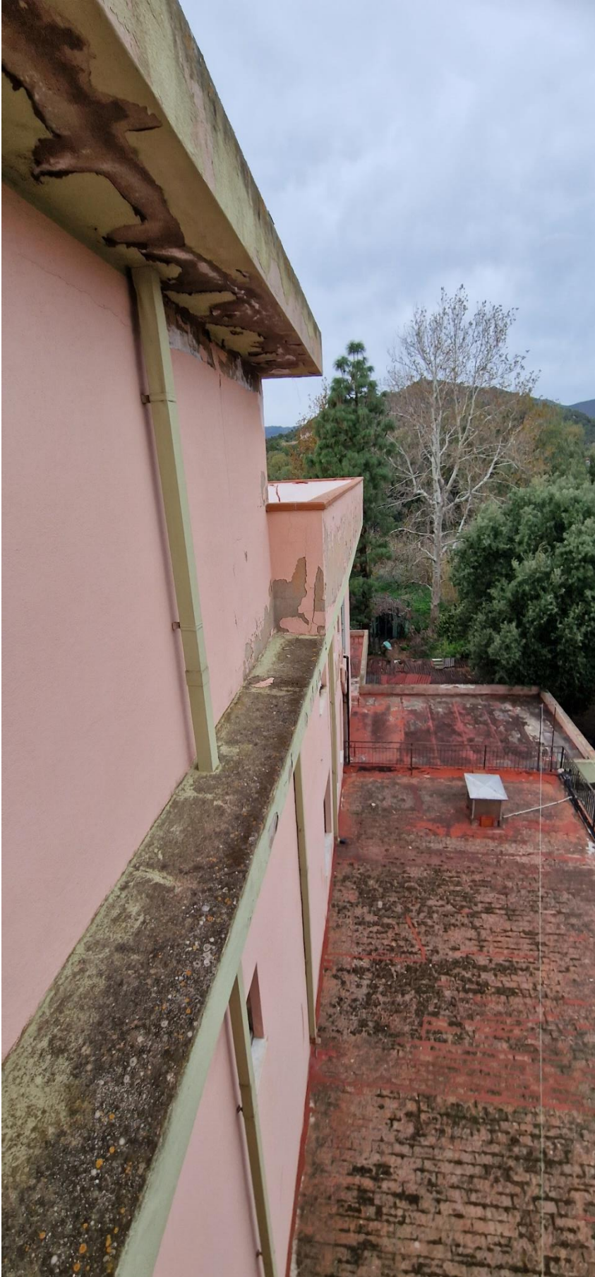
Figura 57 VEDUTA LASTRICO SOLARE SOPRA PIANO TERRA
