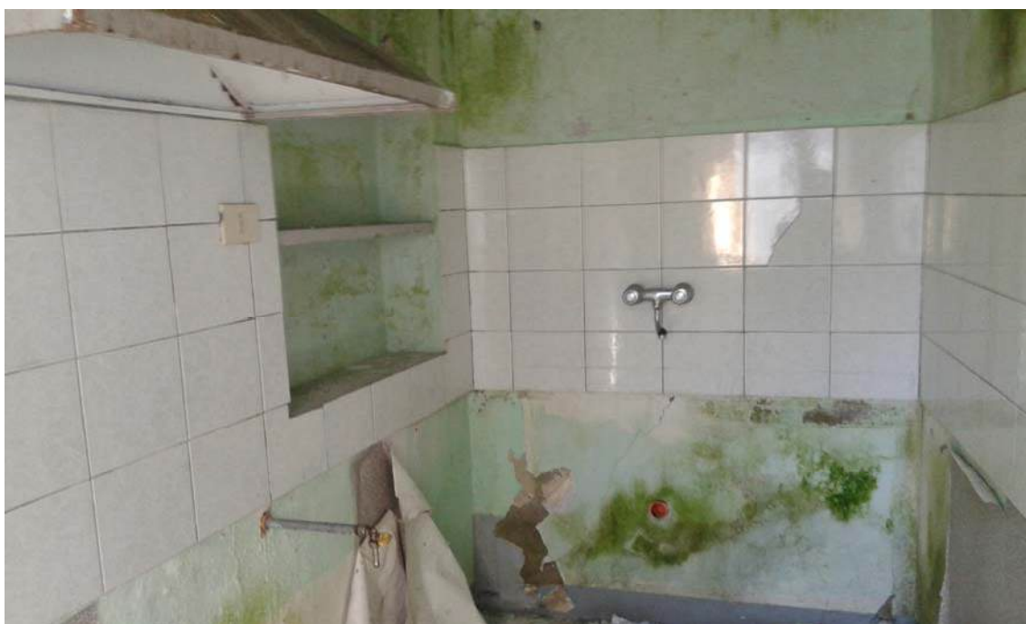
Foto n.25: abitazione ad Assoro, bagno piano terra
