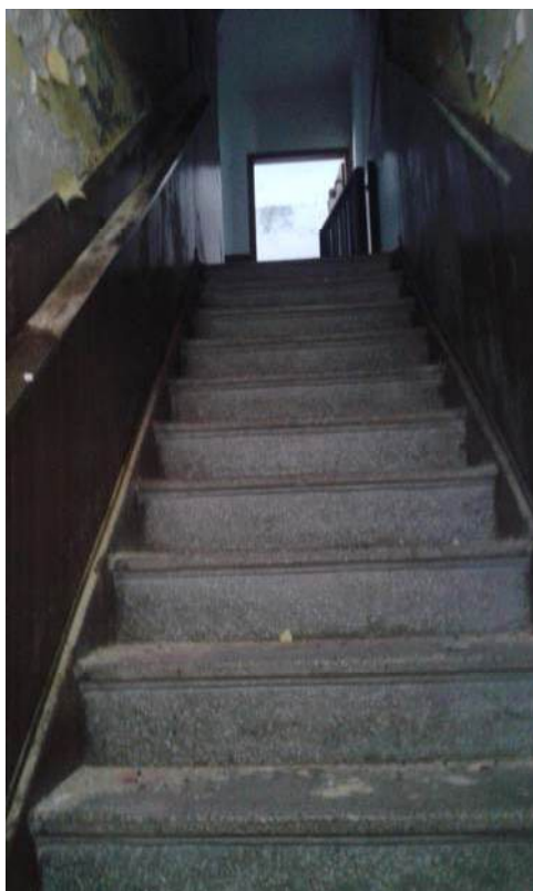
Foto n.27: abitazione ad Assoro, scala di accesso al piano primo
