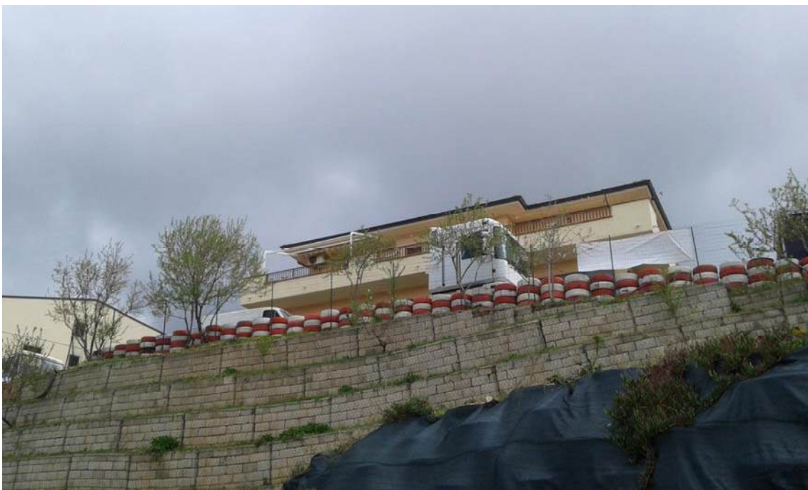
Foto n.20: terreno a Nissoria c.da Croce, muro di contenimento
