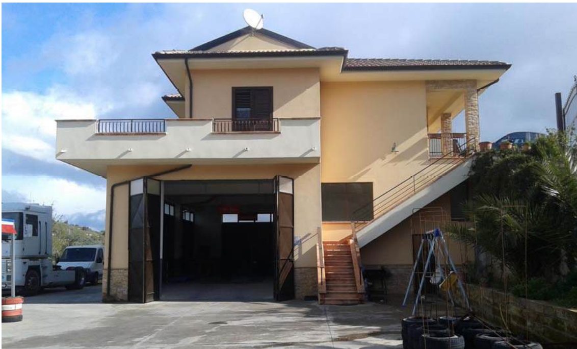
Foto n.2: abitazione a Nissoria, vista prospetto ovest
