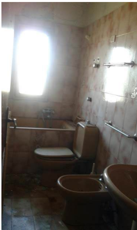
Foto n.28: abitazione ad Assoro, bagno al piano primo
