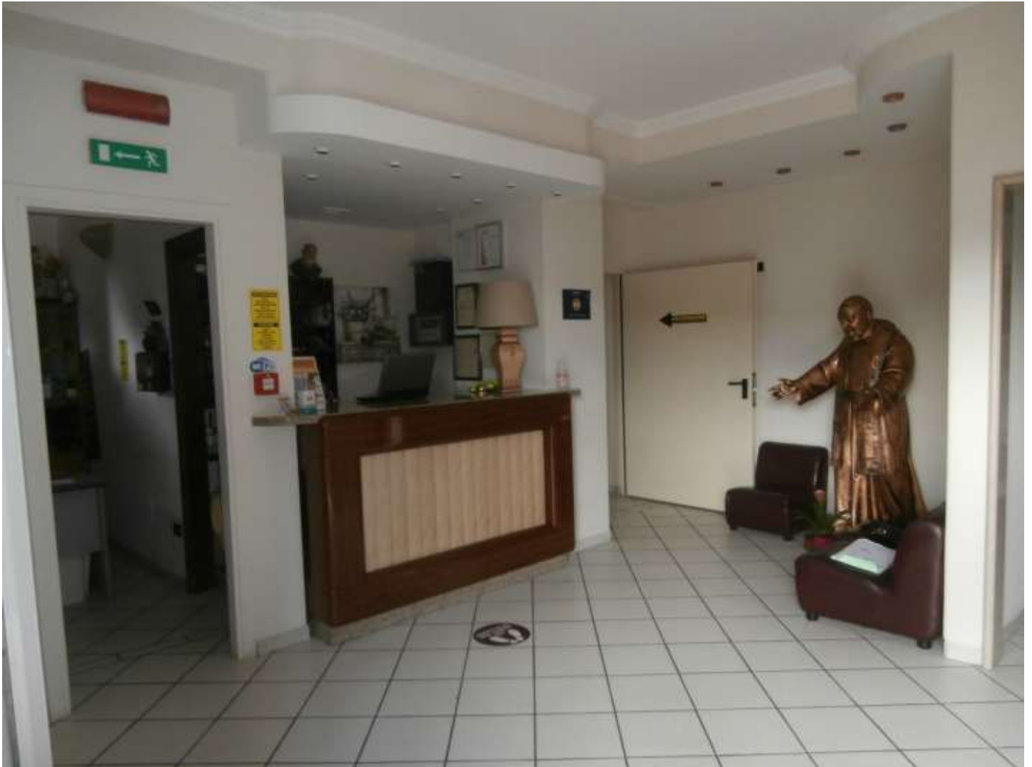
FOTO F.I.T.1: la Hall a p.t. dell'Hotel, in evidenza: a sx la porta d'accesso al locale ufficio, a centro la reception, a dx la porta che dà al vano scala-ascensore; la pavimentazione ed i battiscopa in materiali ceramici, gli intonaci civili a pareti e soffitti, alcuni ribassamenti in cartongesso e le tinteggiature con idropitture murali.
