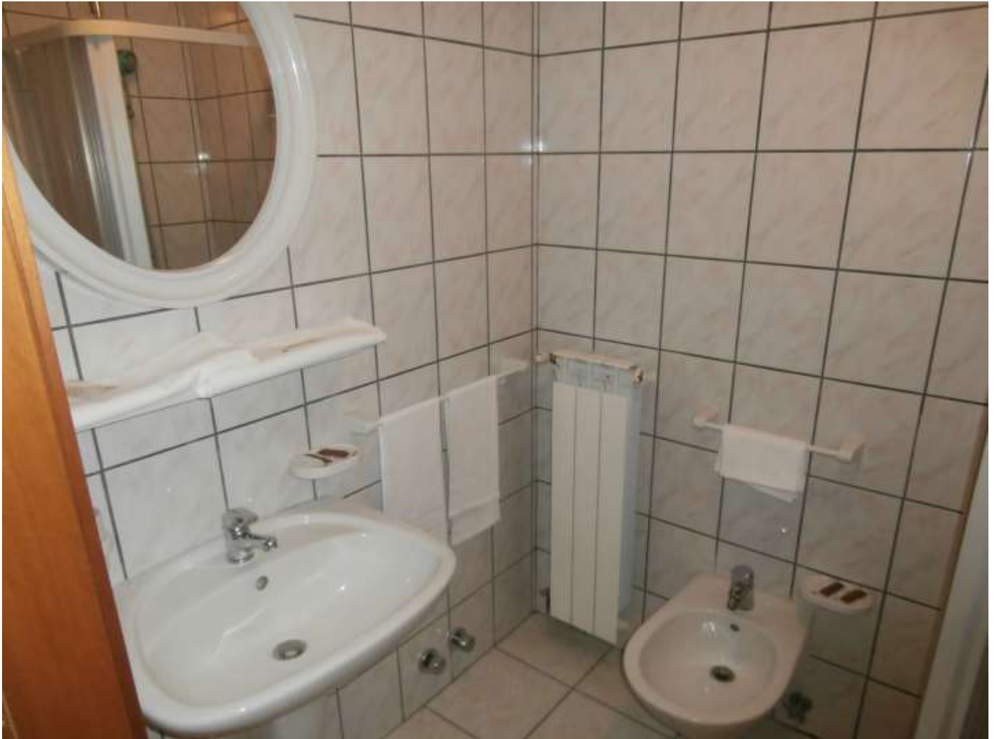
FOTO F.I.III.21: il bagno della camera n.43 a piano terzo dell'Hotel, in evidenza: la porta in legno noce del tipo tamburato, la pavimentazione ed i rivestimenti in materiali ceramici, le apparecchiature igienico-sanitarie con accessori in ottone cromato.
