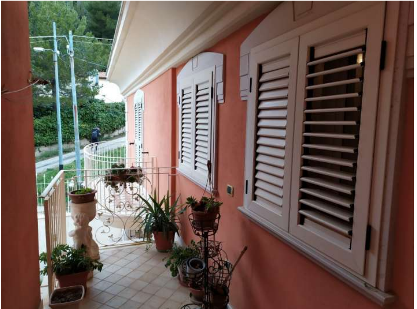
FOTO F.VIII.E2: l'immobile oggetto di E.I. lotto VIII, in evidenza: la facciata prospiciente verso via San Gaetano, in particolare le persiane in alluminio a palette orientabili color bianco, le pavimentazioni in gres, le ringhiere in ferro lavorato smaltato color bianco, i coronamenti vari in pietra di Apricena.
