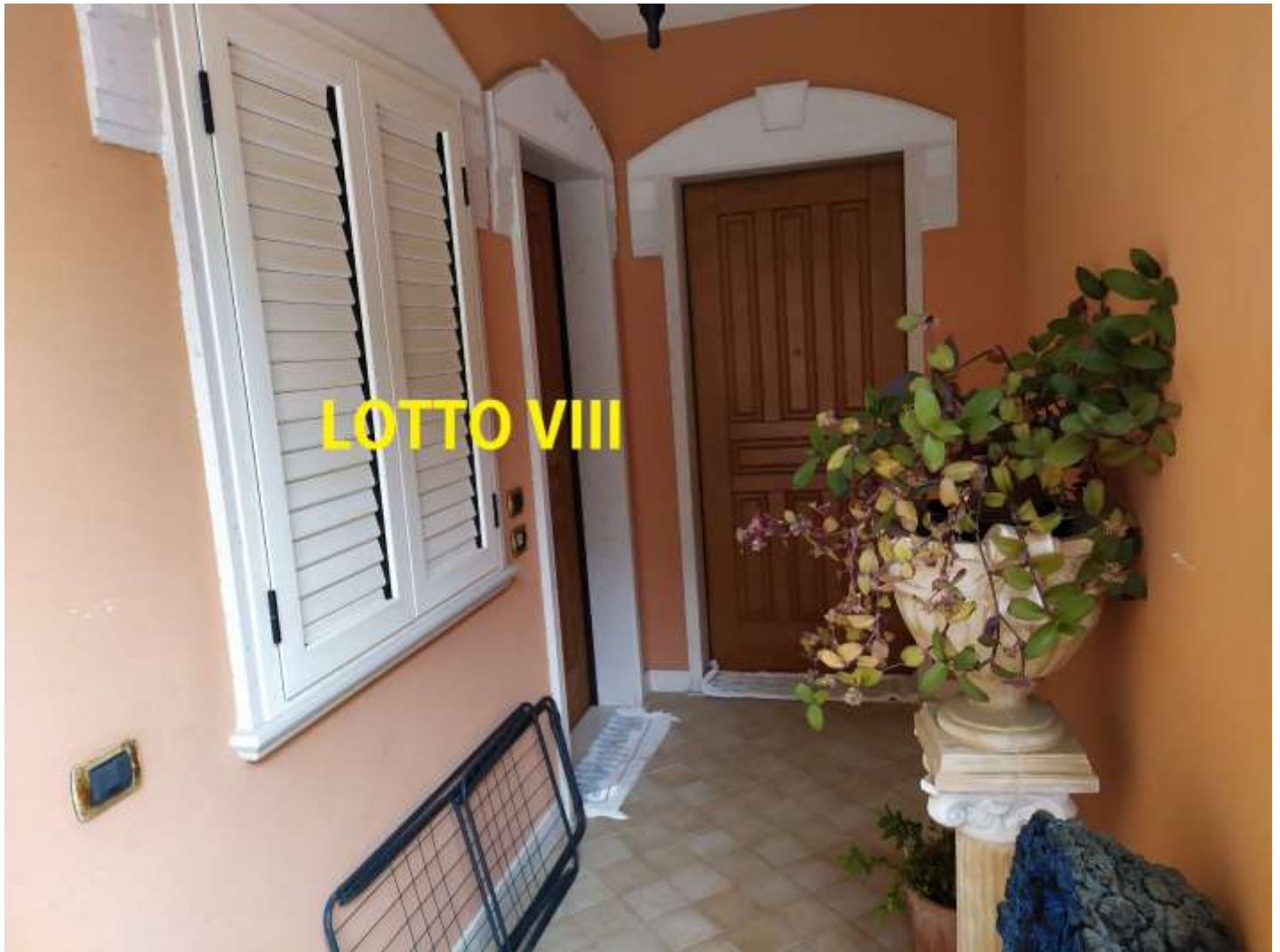
FOTO F.VIII.E1: l'immobile oggetto di E.I. lotto VIII, in evidenza: il portoncino d'ingresso che prende accesso dal vano scala-ascensore (da installarsi) per l'accesso ai piani comune anche ai lotti II, III, IV, V, VII e VIII, nonché una delle persiane della stessa u.i.
