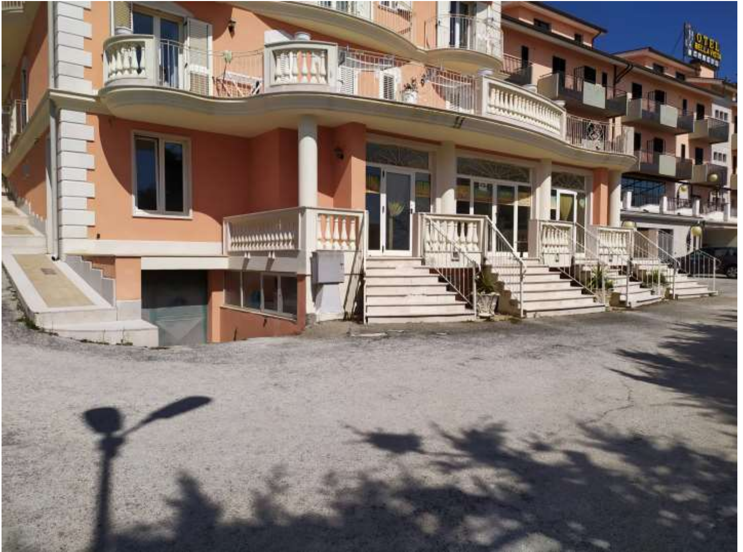
FOTO F.II.E.1: il negozio lotto II, in evidenza: le scalinate di accesso, la balconata antistante e le ampie vetrate ed ingressi.
