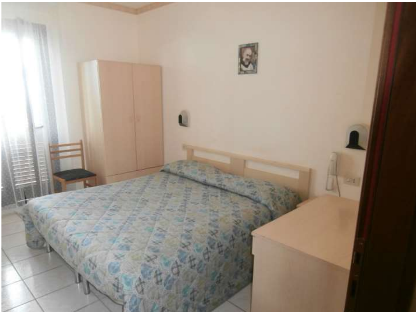
FOTO F.I.I.11: la camera n.4 a piano primo dell'Hotel, in evidenza: le porte in legno noce del tipo tamburato, la vetrata-balcone in alluminio elettrocolorato dotata di persiane orientabili, la pavimentazione ed i battiscopa in materiali ceramici, gli impianti elettrici del tipo sottotraccia, le pareti intonacate a civile e tinteggiate con idropitture murali.
