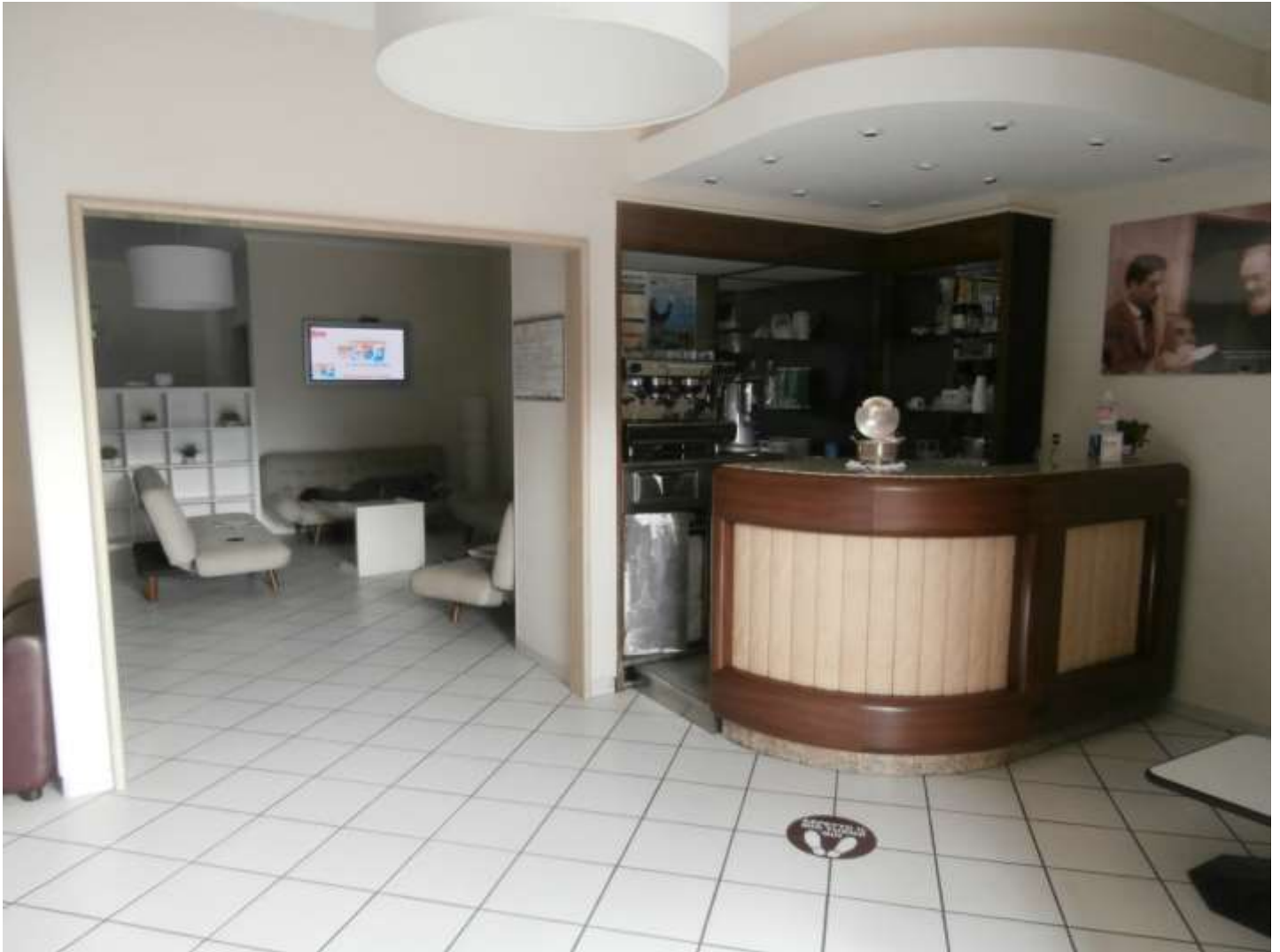
FOTO F.I.T.2: la Hall a p.t. dell'Hotel, in evidenza: a sx l'accesso alla sala ristoro con zoom sulla zona d'attesa, a dx l'angolo bar; la pavimentazione ed i battiscopa in materiali ceramici, gli intonaci civili a pareti e soffitti, alcuni ribassamenti in cartongesso e le tinteggiature con idropitture murali.
