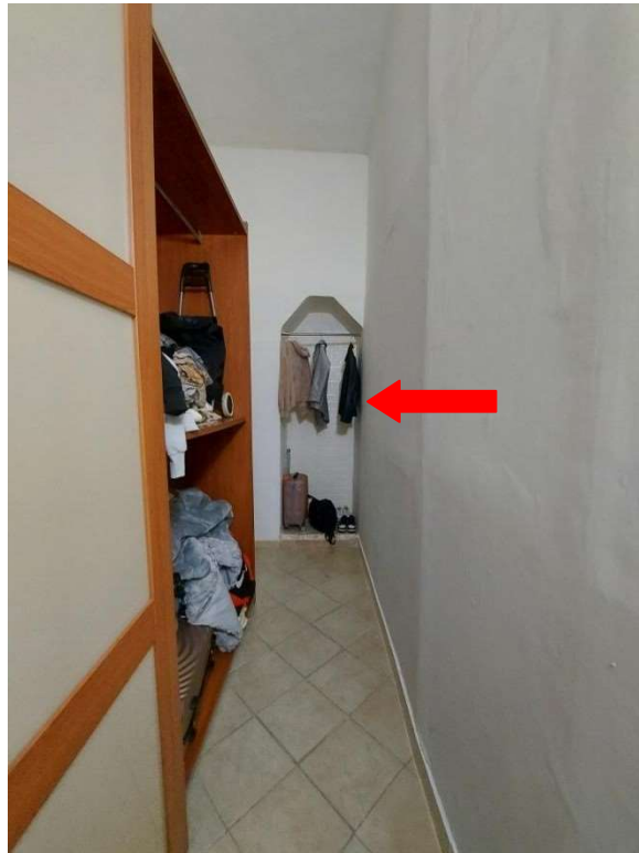
disimpegno - varco accesso locale L2 (murato)
