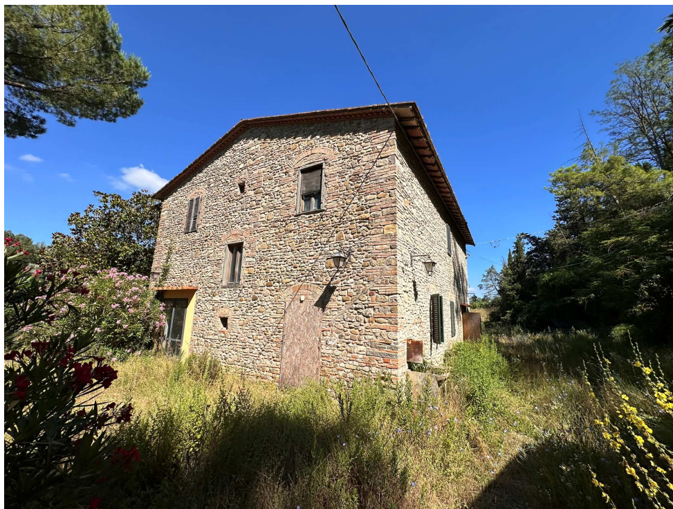
Immagine dei fabbricati in trattazione
