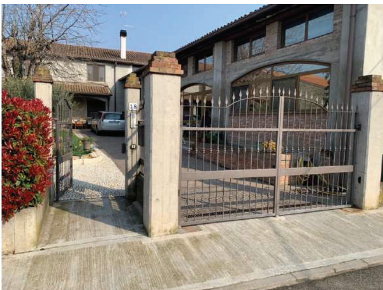
Vista ingresso carrabile e pedonale
