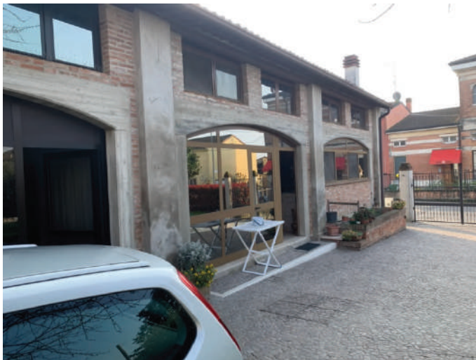
Vista esterna portico
