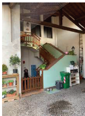
Portico con scala di accesso al piano superiore
