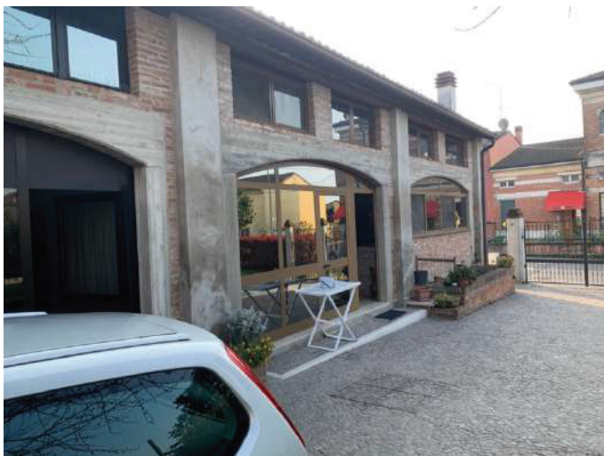
Vista esterna portico
