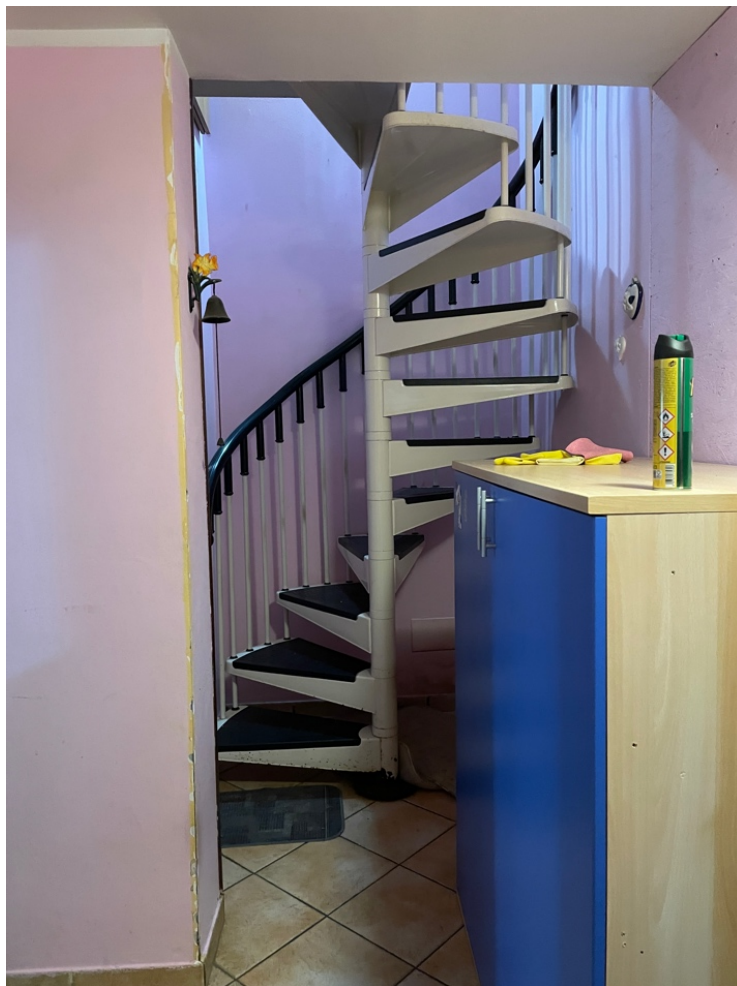
Foto 13. Scala a chiocciola interna (vista al piano interrato).
