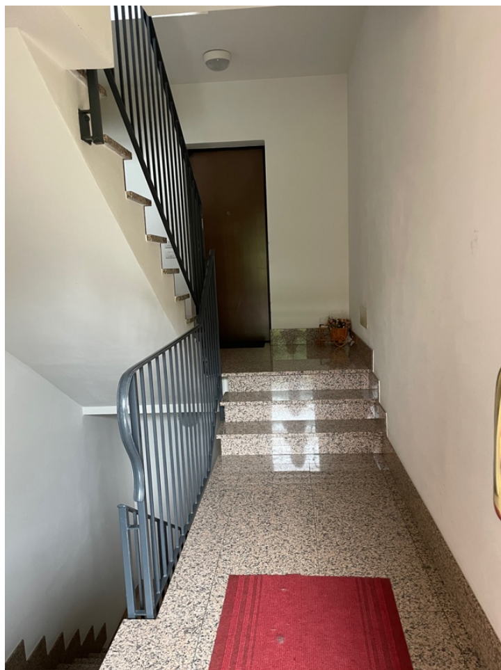
Foto 4. Vano scale condominiale.
