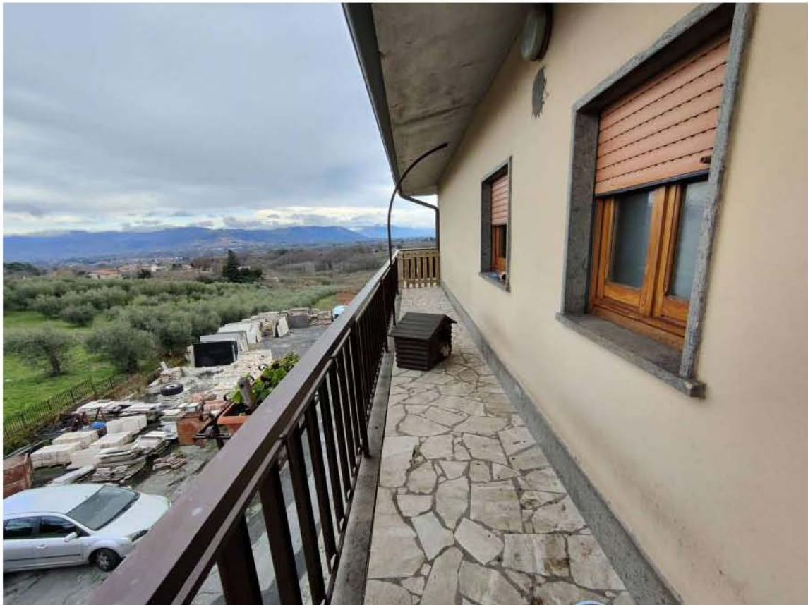
Sopra e sotto: vedute della balconata che circonda l'unità immobiliare in esecuzione (Foto Ticconi, gennaio 2024)
