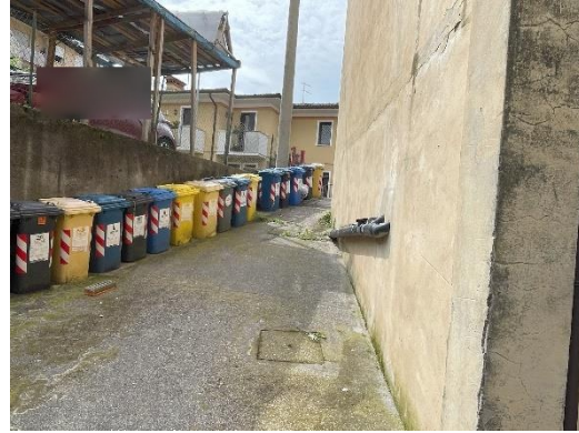
Foto 4 - Veduta rampa di accesso
