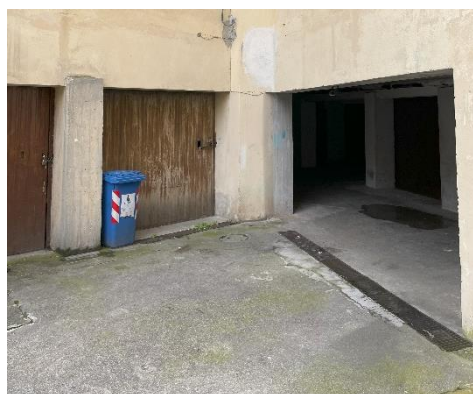
Foto 14 - PINT. – ingresso alle autorimesse
