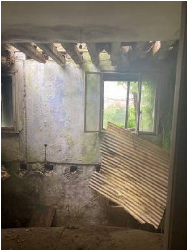
Foto interni piano primo: stanza con solaio crollato, ripostiglio, bagno
