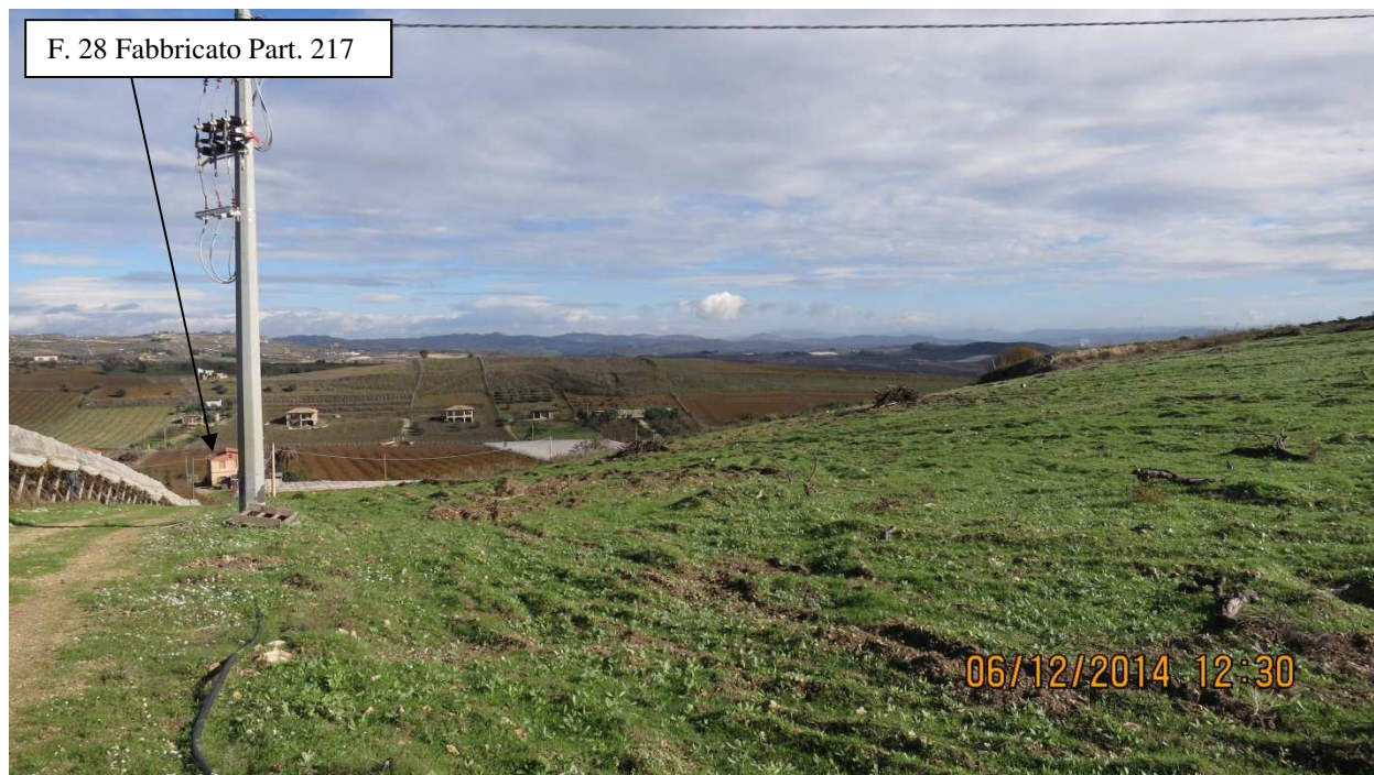
FOTO 1: Scorcio della zona in esame con direzione di avanzamento sulle particelle 38, 13, 151 . Sullo sfondo indicata da una freccia il fabbricato di cui alla particella 217 , escluso dal presente procedimento ed utilizzato solo come riferimento.
