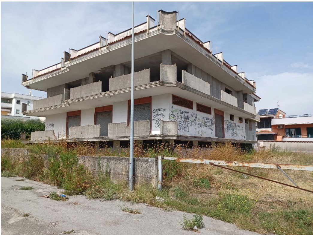
FOTO N°2: PROSPETTO LATERALE DX
