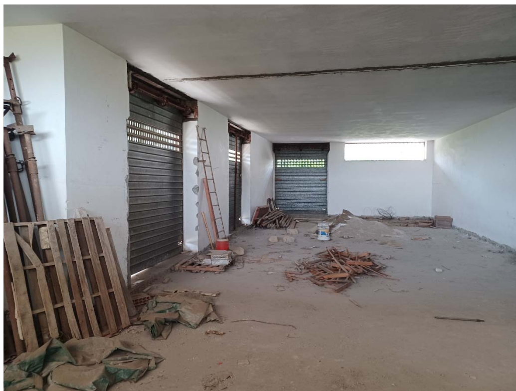
FOTO N°10: DEPOSITO AL PIANO RIALZATO (BENE N.1 DEL LOTTO)
