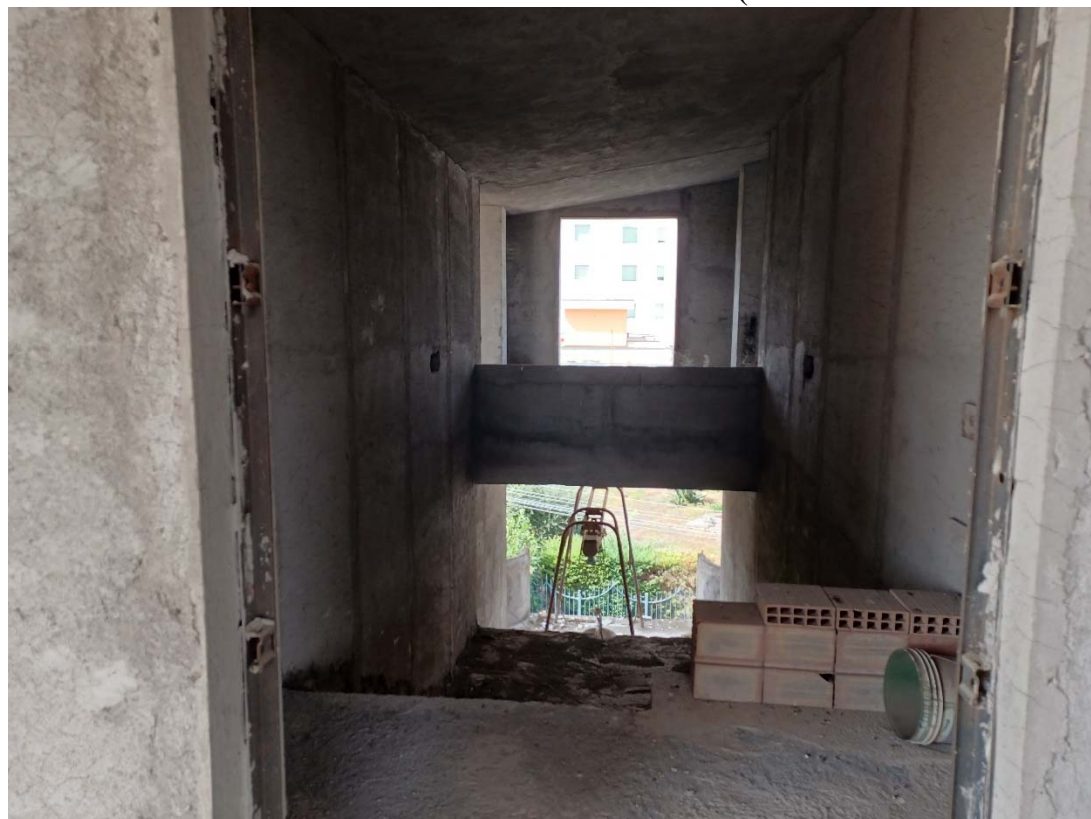
FOTO N°14: DEPOSITO AL PIANO SECONDO (BENE N.3 DEL LOTTO)
