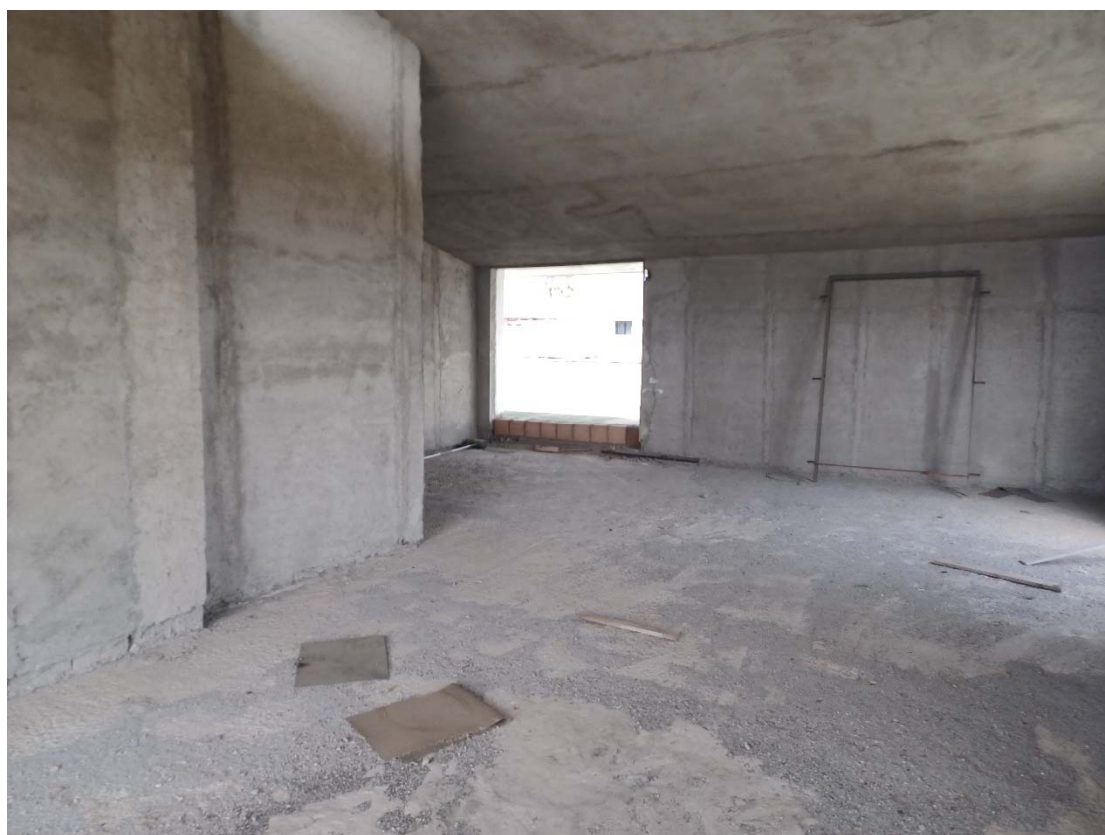
FOTO N°13: DEPOSITO AL PIANO SECONDO (BENE N.3 DEL LOTTO)
