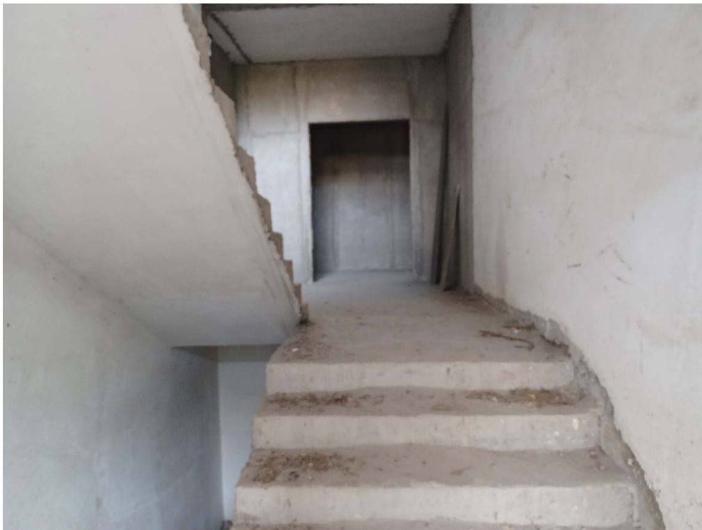
FOTO N°8: RAMPA DI SCALE INTERNA
