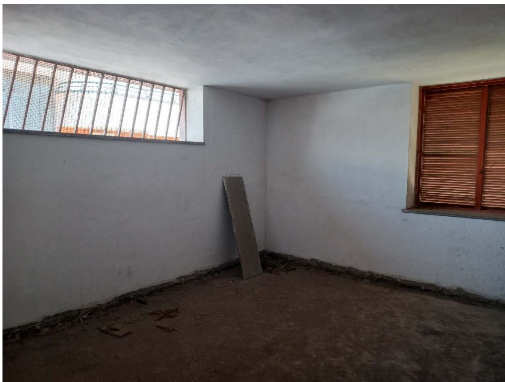
FOTO N°9: DEPOSITO AL PIANO RIALZATO (BENE N.1 DEL LOTTO)
