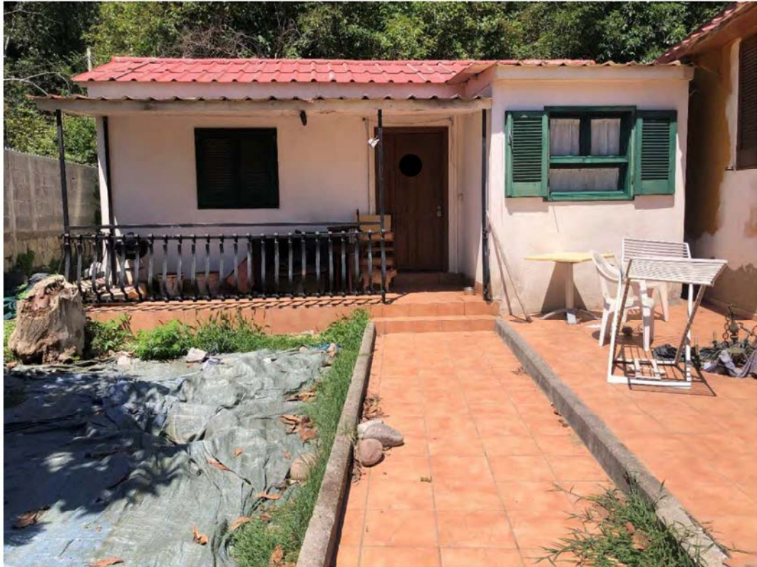
SUB 34 - Foto 2 : Vista esterna dal vialetto di accesso
