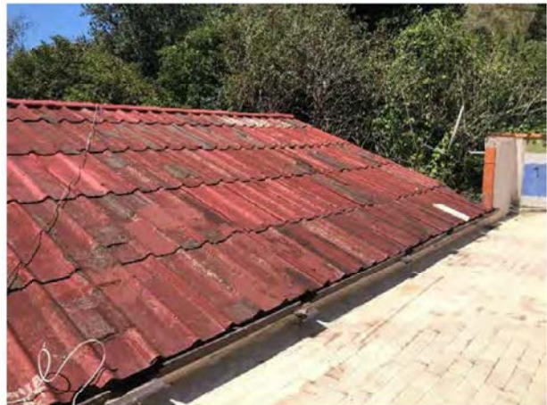
SUB 33 - Foto 20-21 : Vista del terrazzo
