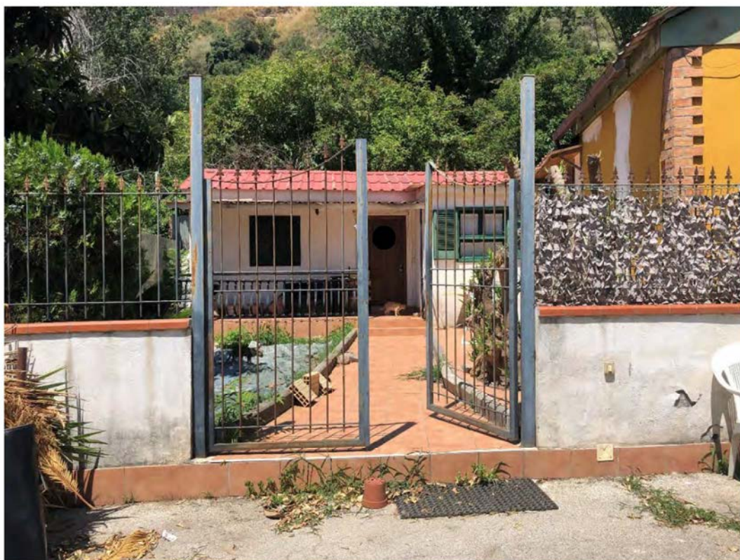
SUB 34 - Foto 1 : Vista esterna dal cancello di ingresso
