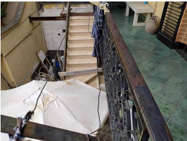
Scala esterna e ballatoio
